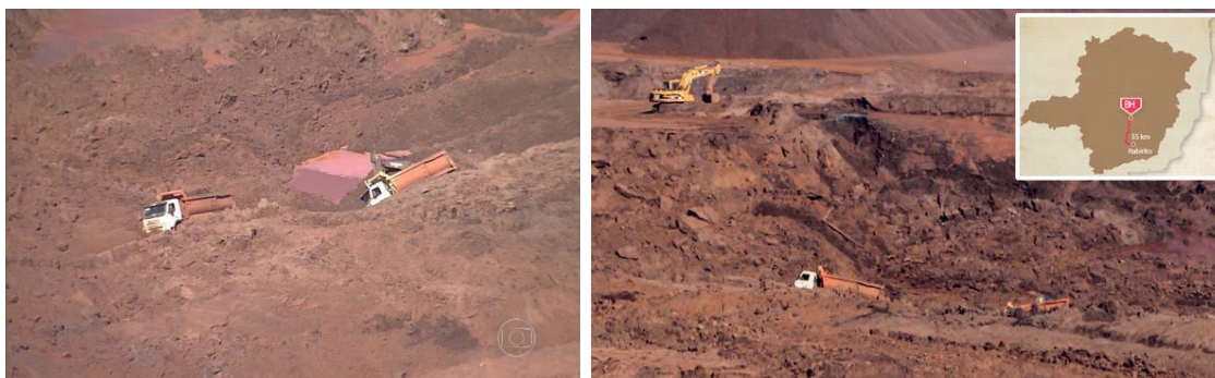
Figura 4 - Parte da destruição causada pelo rompimento da barragem B1.
