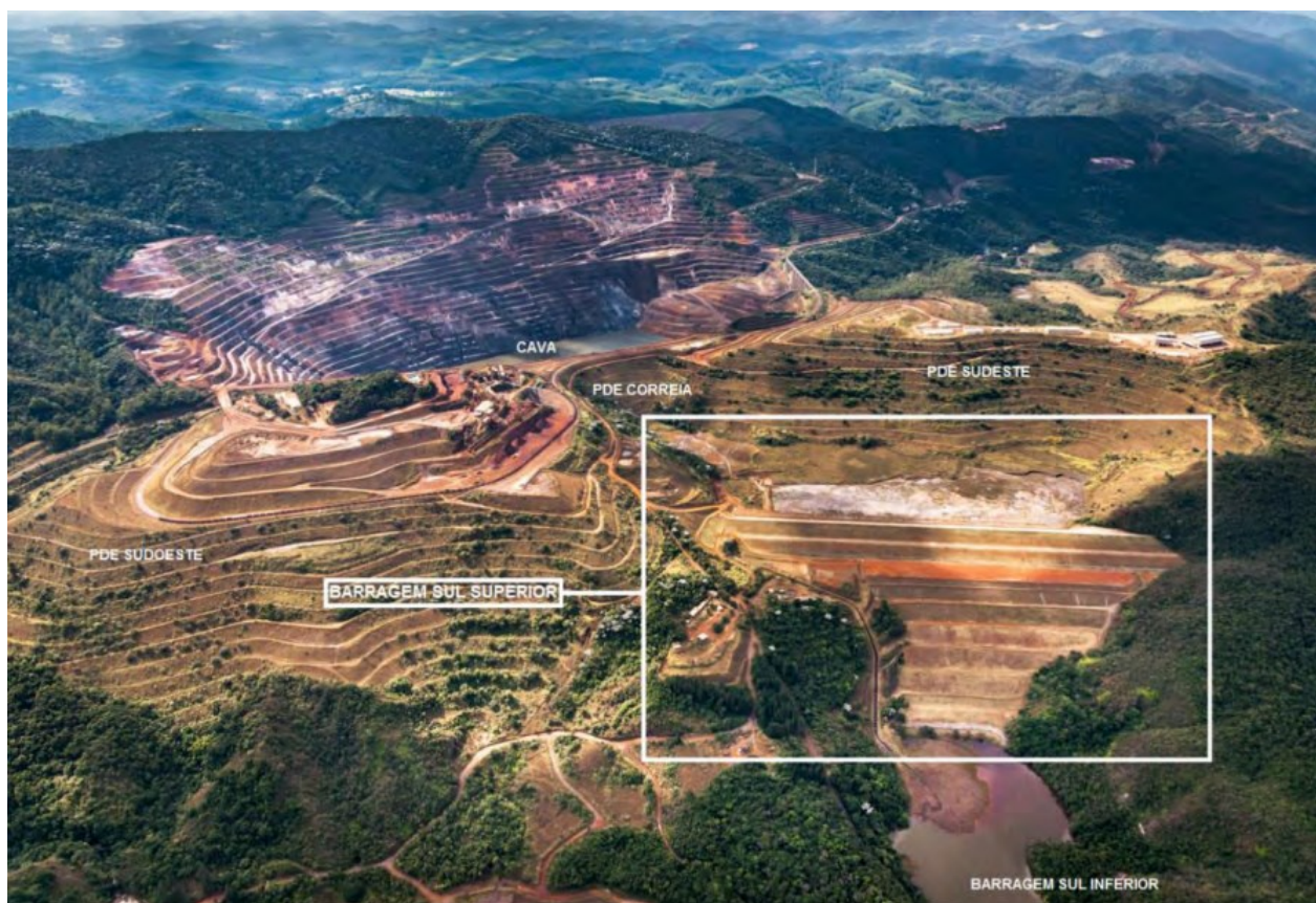
Figura 16 - Vista panorâmica da Mina de Gongo Soco, com a barragem Sul Superior em destaque.
