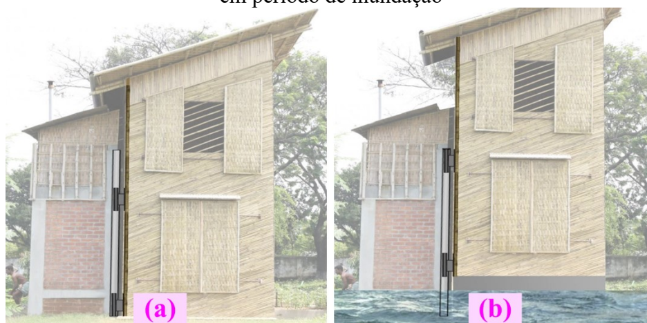
Figura 23 – LIFT House , em Daca: (a) habitação em período de normalidade e (b) habitação em período de inundação
