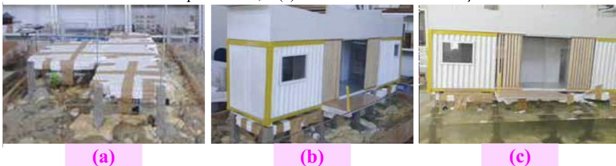
Figura 22 – Casa contêiner flutuante: (a) construção da plataforma de flutuação; (b) protótipo sobre a plataforma; e (c) teste do sistema de flutuação
