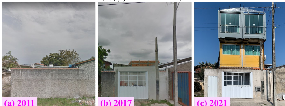
Figura 53 – Modificações no terreno da habitação 3: (a) terreno em 2011; (b) terreno em 2017; (c) e habitação em 2021.
