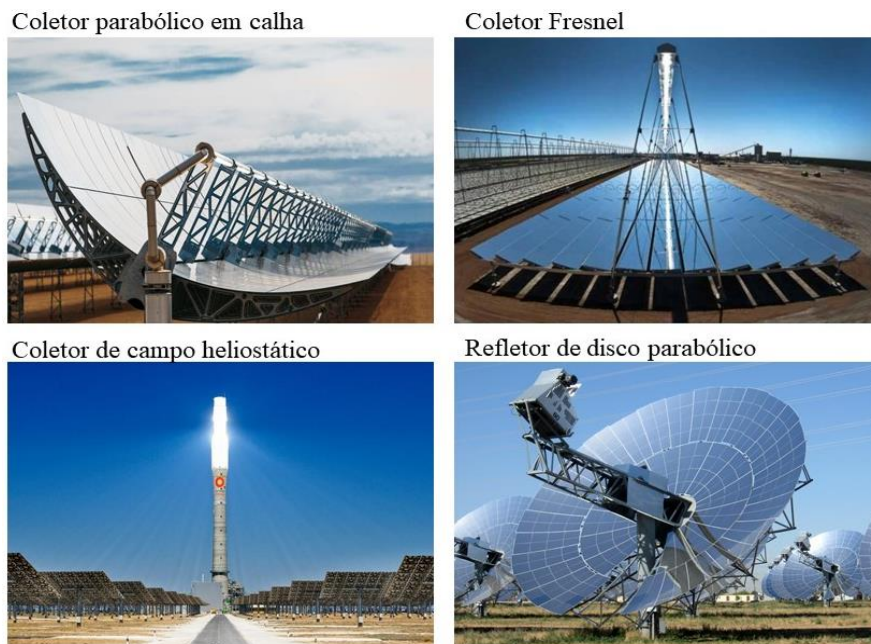
Figura 9 - Principais tecnologias CSP.
