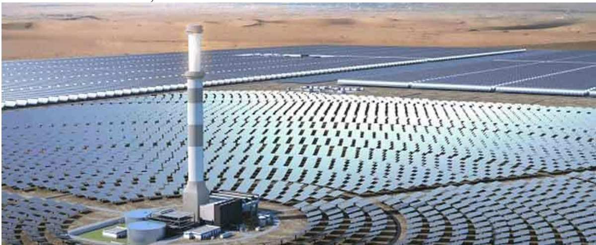
Figura 14 - Planta solar NOOR Energy 1 com potência instalada de 700 MWe e TES de até 15 h, localizada em Dubai nos Emirados Árabes Unidos.
