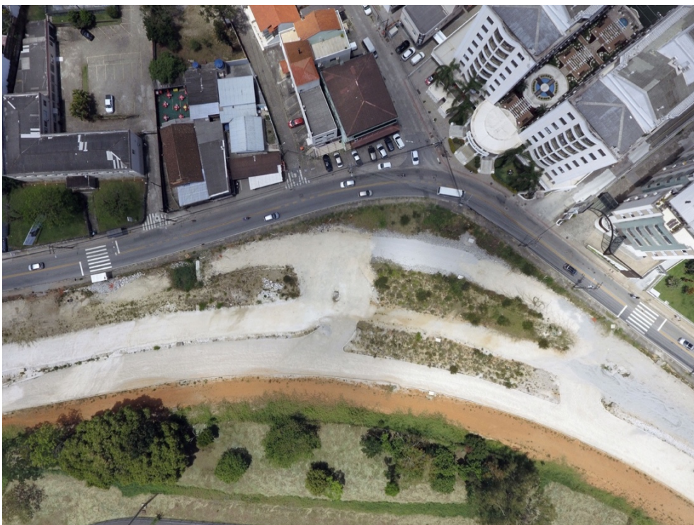
Figura 23_O “cinturão verde” em uso, obras de duplicação da Avenida Deputado Antônio Edu Viera na porção sul do campus Trindade. Florianópolis, 2020. Fotografia: Felipe Finger. Fonte: Acervo LEUr-UFSC.
