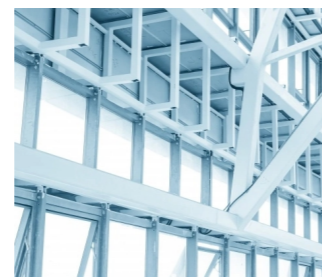
ESTRUTURA METÁLICA COM PINTURA NAVAL ANTICORROSIVA NA COR BRANCA
