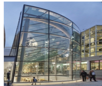
VIDRO TRANSLUCIDO COM FILTRO SOLAR ESQUADRIA INOX
