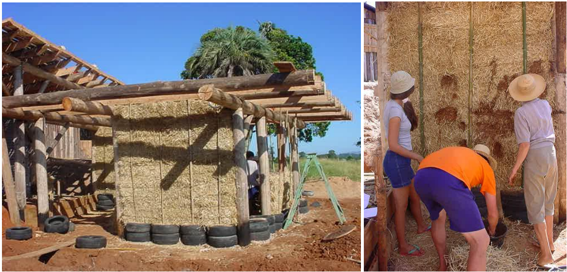
Figuras 13 e 14: Paredes de fardo de palha estruturadas com bambu
