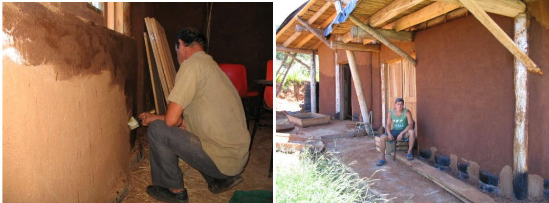
Figuras 17 e 18: Impermeabilização das paredes para proteção da chuva
