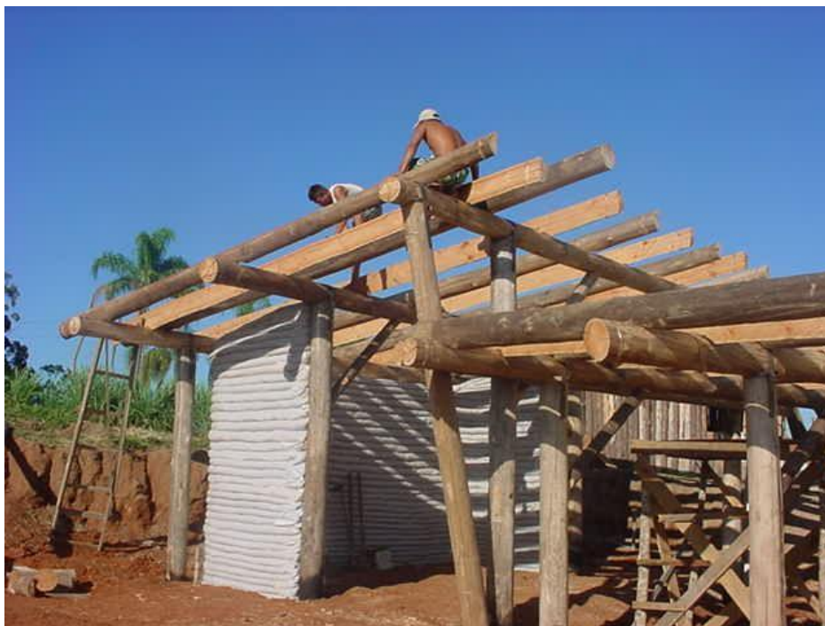
Figura 12: Estrutura da obra construída no Centro de Formação Sepé Tiarajú
