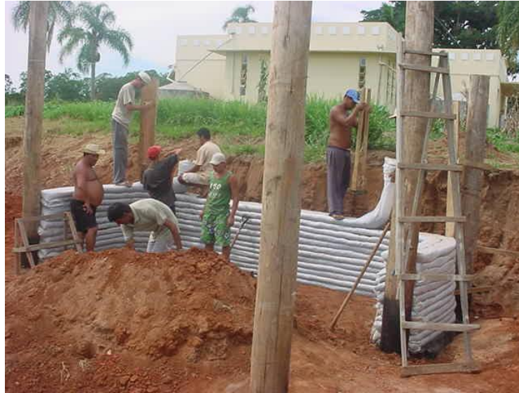
Figura 9: Construção de uma parede de Super Adobe
