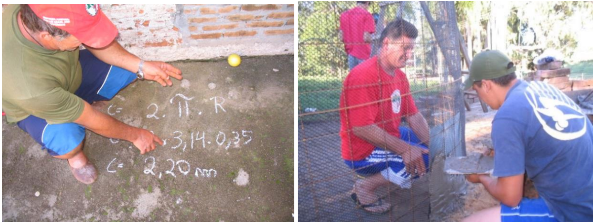
Figuras 30 e 31: Cálculo da circunferência da cisterna e construção das paredes
