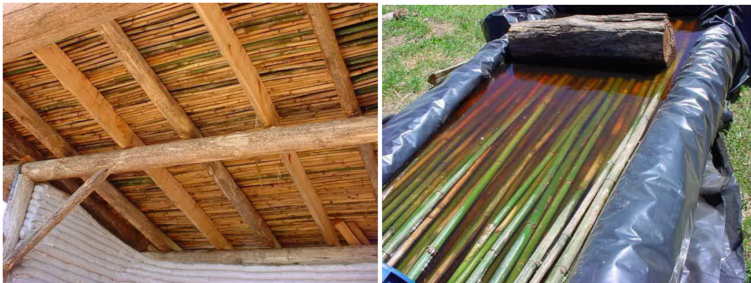
Figuras 19 e 20: Estrutura do telhado vivo e tratamento do bambu
