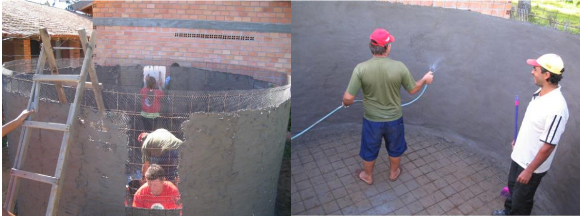
Figuras 32 e 33: Estrutura de ferro armado recebendo a argamassa e a cura do cimento
