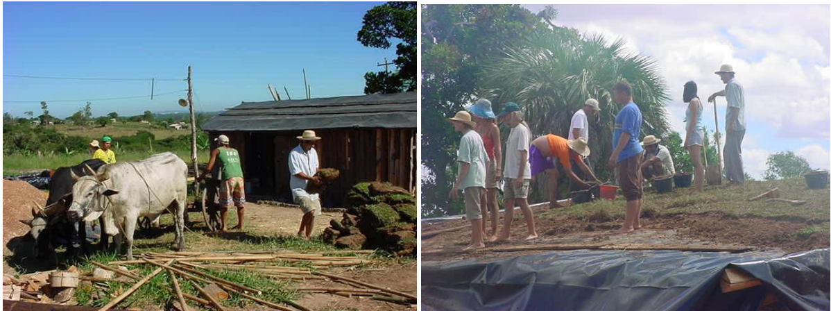
Figuras 21 e 22: Construção do telhado vivo com grama do local
