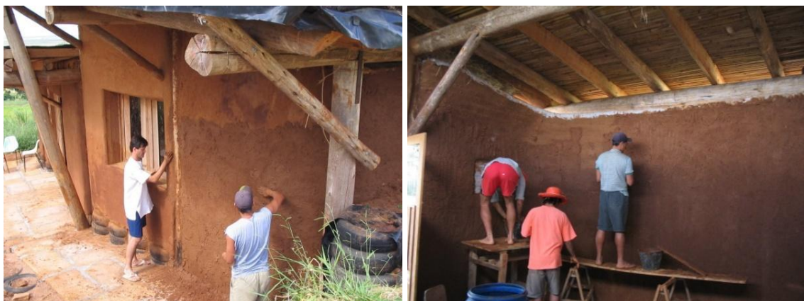
Figuras 15 e 16: Reboco com terra
