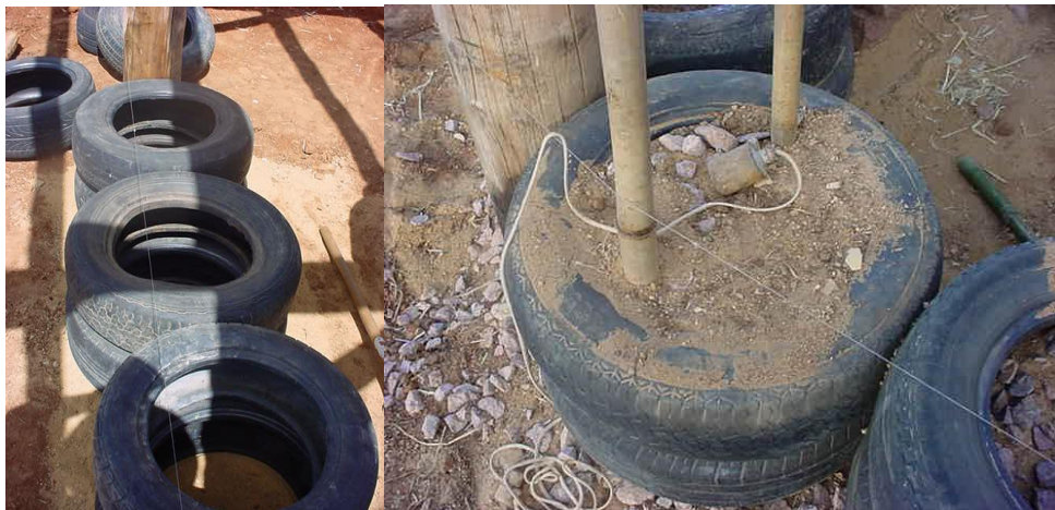
Figuras 10 e 11: uso do pneu para alicerce
