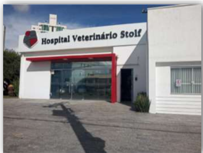
Figura 24 – Fachada do Hospital Veterinário Stolf em Lages – SC
