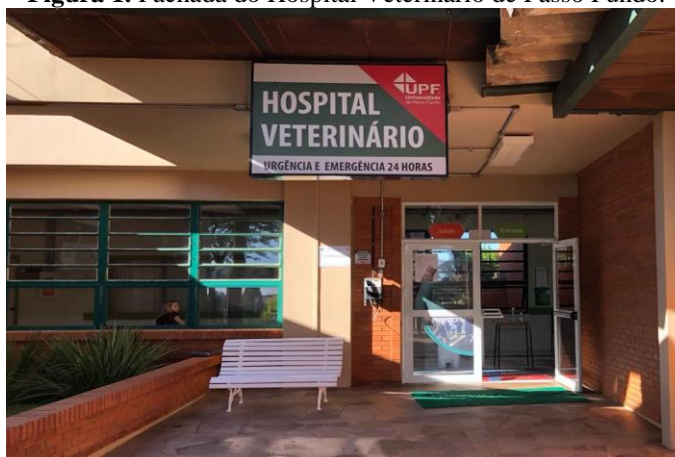
Figura 1. Fachada do Hospital Veterinário de Passo Fundo.
