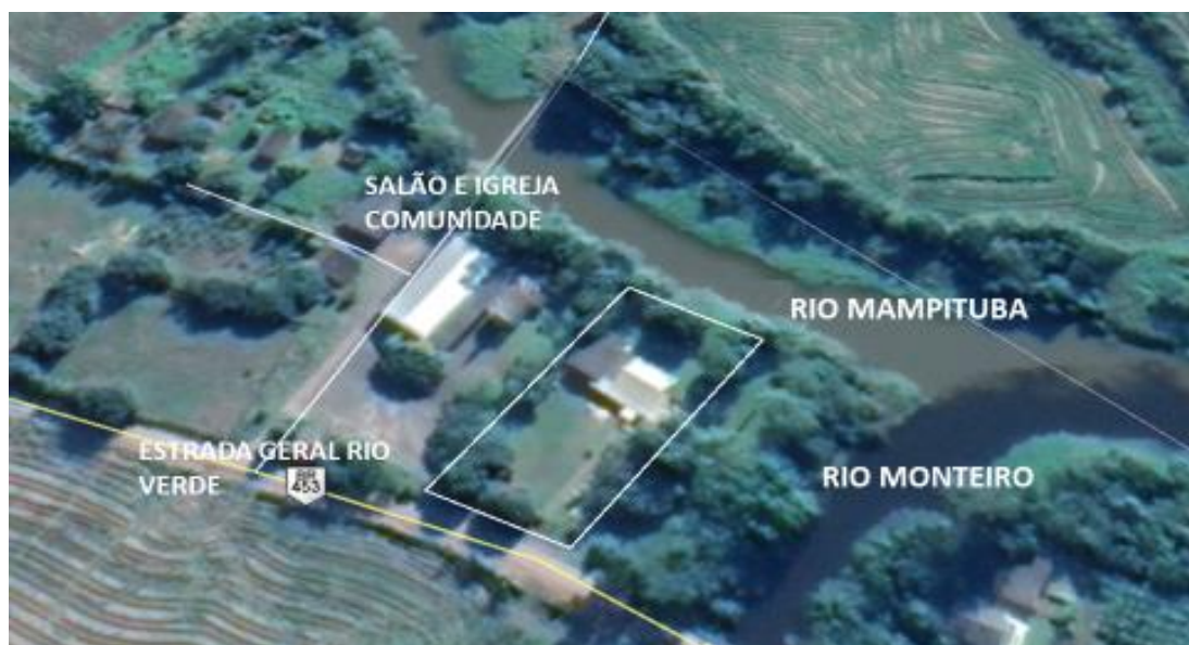
Figura 5: Imagem do Google Earth, identificando no polígono a área da Escola.
