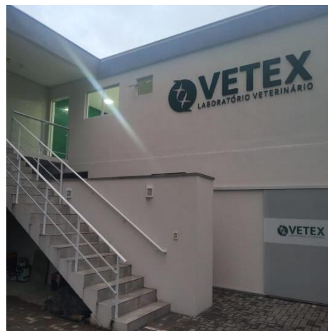
Figura 1. Fachada unidade VETEX Blumenau
