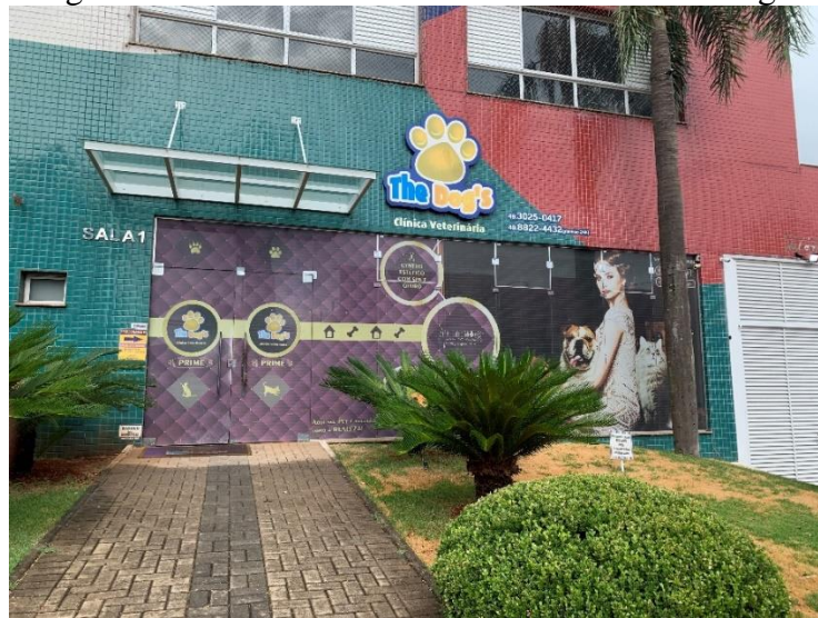
Figura 18– Fachada da Clínica Veterinária The Dog’s
