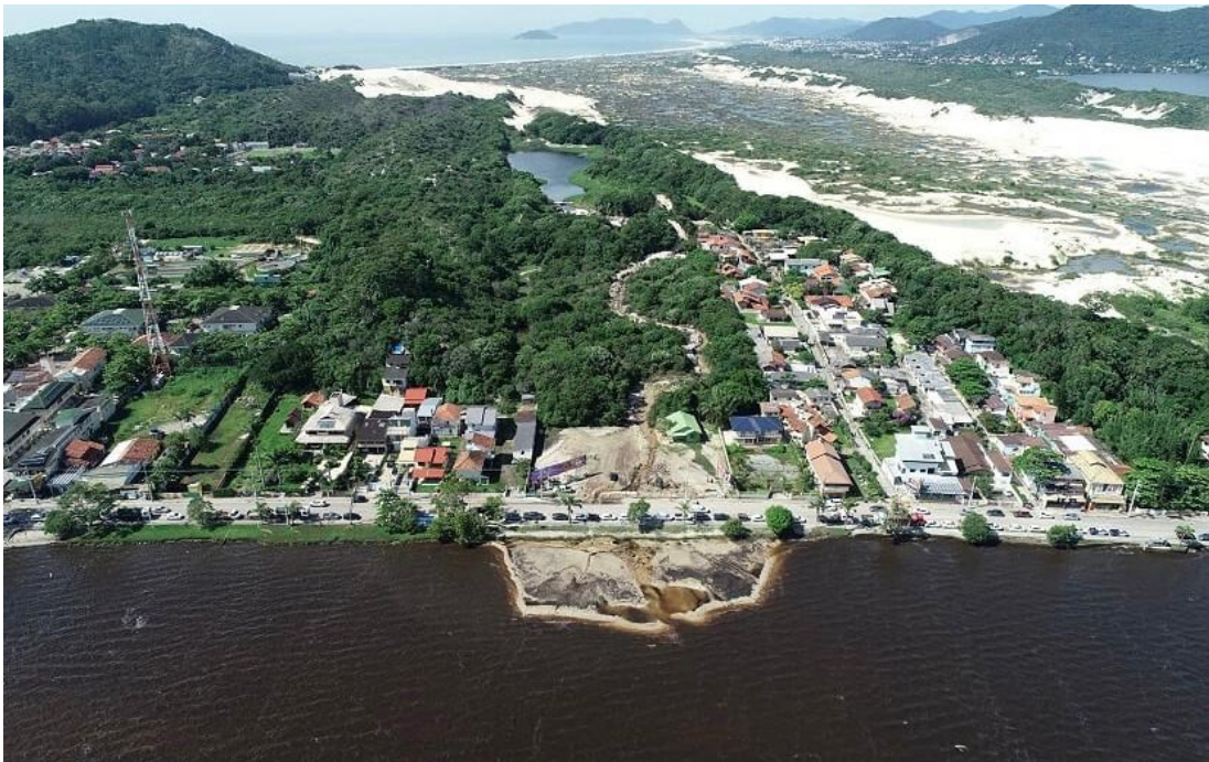
Figura 3: Trajeto percorrido pelos efluentes após o rompimento da Lagoa de Evapoinfiltração.
