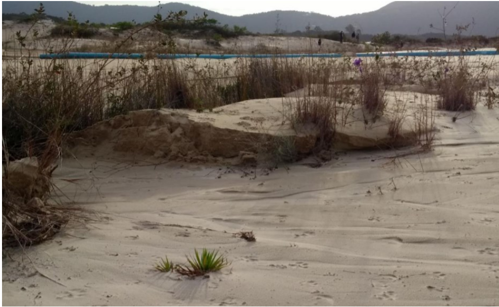
Figura 4: Tubulação de bombeamento em meio às dunas.
