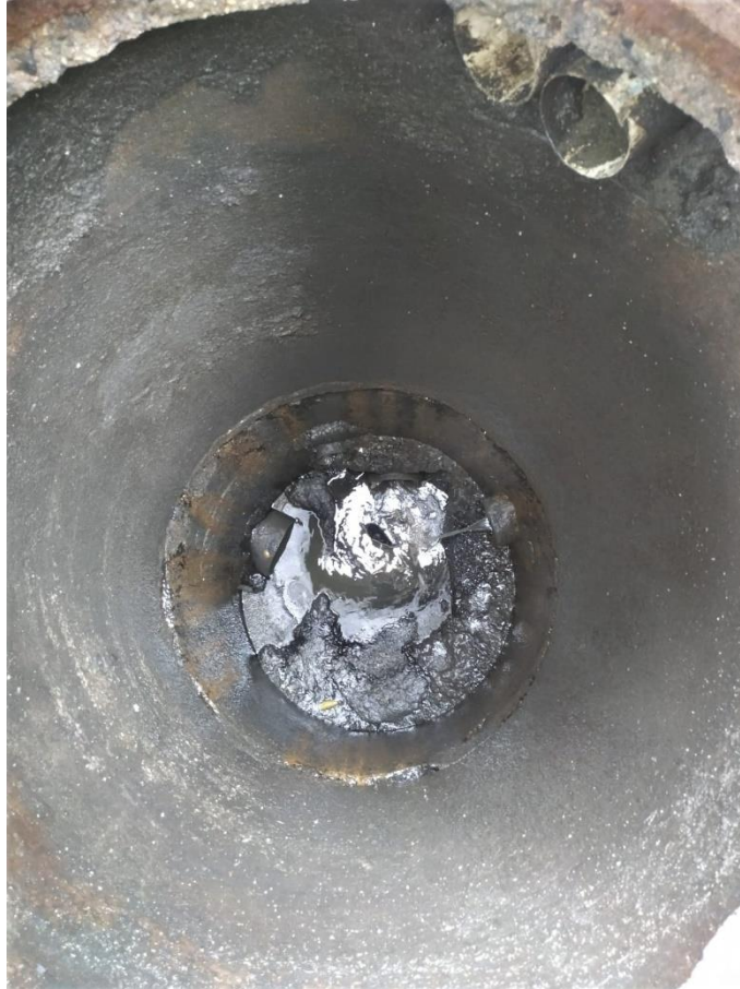
Figura 15 – Etapa de recepção e gradeamento do esgoto.
