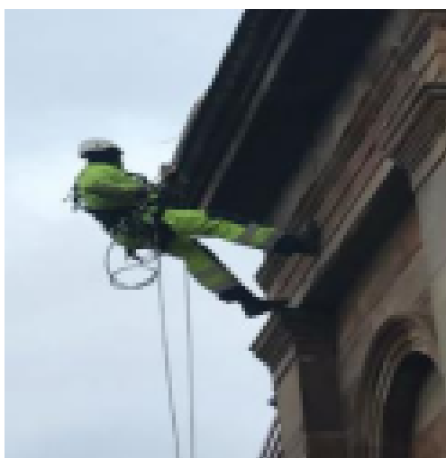
(a) Inspeção visual através de corda/rapel
