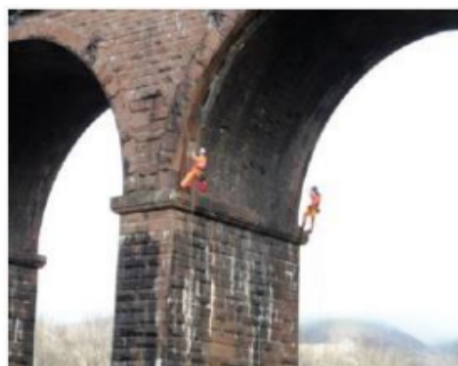
(b) Inspeção visual através de corda/rapel
