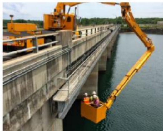
(b) Inspeção visual através de veículo especial
