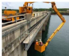
(d) Inspeção visual através de veículo especial
