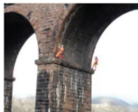
(b) Inspeção visual através de corda/rapel
