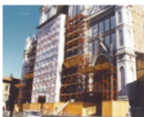
(a) Inspeção visual através de andaime
