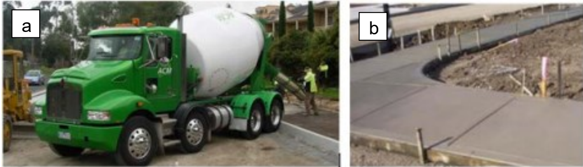
Figura 4 – Aplicações de geopolímeros pela empresa Zeobond: a) Caminhão concretando calçamento em Templestowe; b) Calçamento já finalizado em Lyndarum State
