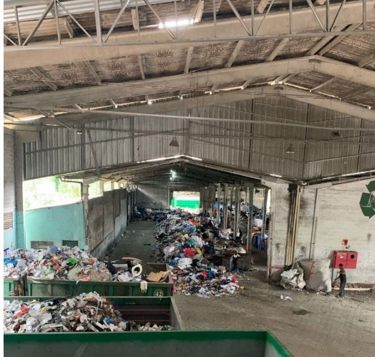
Figura 32 - O galpão destinado a separação dos recicláveis.
