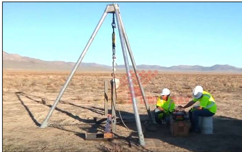
Figura 6 – Prova de carga de arrancamento com tripé como elemento de reação.
