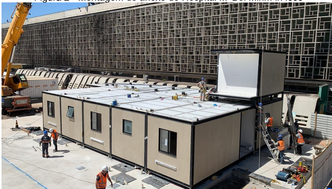
Figura 2 - Montagem do anexo do Hospital M' Boi Mirim in loco
