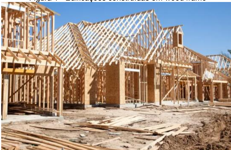
Figura 1 - Edificações construídas em wood frame
