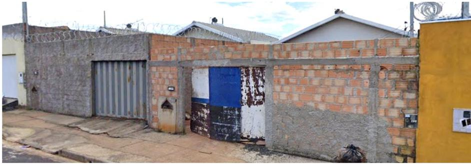
A edificação com a implantação dos muros foi chamada de “CB+Muros”. Para os muros, em todos os casos em que houve sua inserção, foi considerada a composição de blocos cerâmicos de seis furos, reboco de 2 cm em ambos os lados e absorvância à radiação solar de 0,4. A disposição dos muros e da edificação no terreno é ilustrada na Figura 13.
