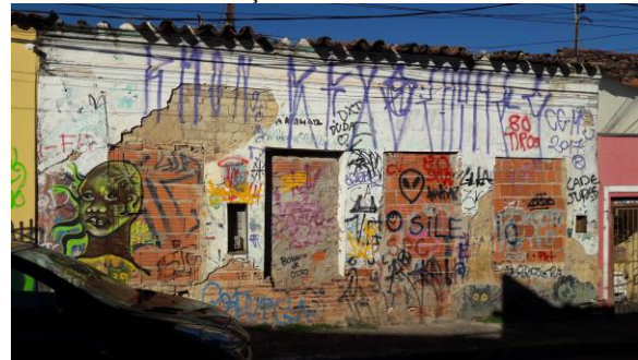
Figura 12: Pichação na Rua do Meio, próximo à Praça da Mandioca.
