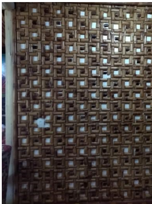
Figura 139: Parede do corredor com aplica o de bambu e cola branca. Cria o da fam lia (foto de 2020)
