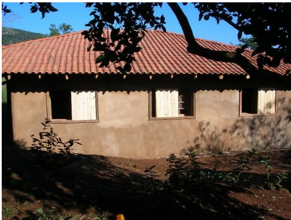
Figura 64: Paredes e rebocos de terra e esquadrias de demolição. Foram acrescentadas folhas de pinus nas janelas.
