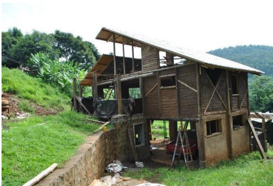
Figura 109: Estrutura em madeira e fechamentos em terra. Uso prioritário de materiais da propriedade (foto de 2009).
