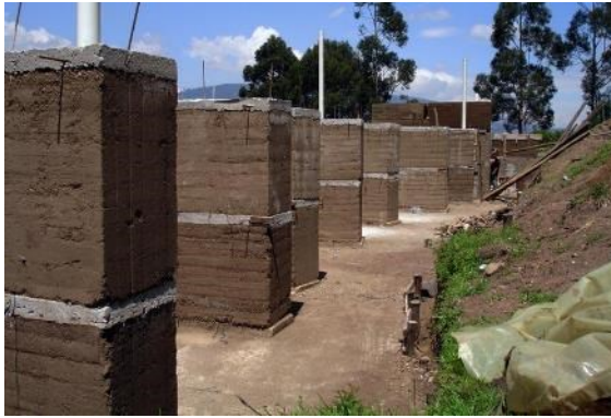
Figura 14: Execução de edificação em taipa de pilão. Fonte: Al Borde Arquitectos.
