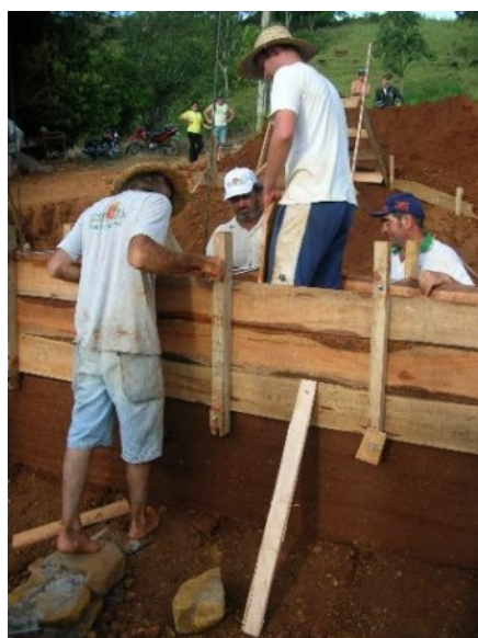
Figura 74: À esquerda, execução de paredes em taipa de pilão com o solo local. À direita, paredes de terra ensacada apoiada sobre base de taipa de pilão. Foto de 2009.
