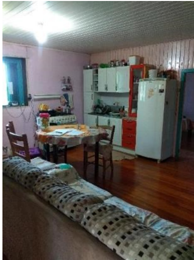
Figura 109: A área insuficiente de esquadrias torna necessário o uso de luz artificial durante o dia.
