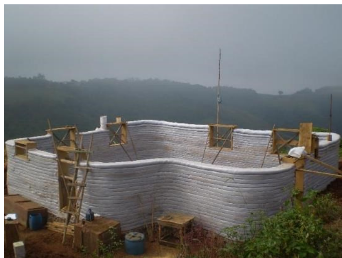
Figura 117: Edificação 05 em etapa de obra (2009).
