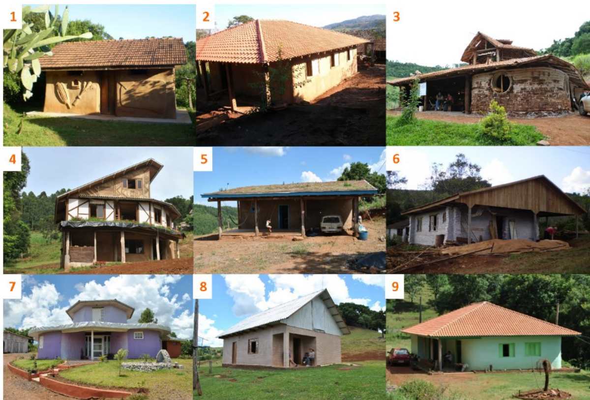
Figura 12: Edificações mapeadas no Oeste Catarinense (PROMPT, 2012). Das nove edificações avaliadas somente uma (número 1) não foi financiada pelo PSH.
