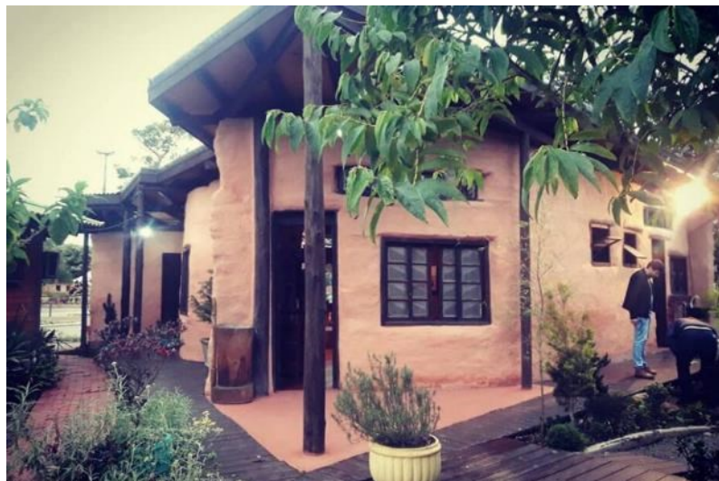
Figura 30: Casa do Chá, Florianópolis, 2017. Projeto da autora. Construção Baobá Construções Sustentáveis.
