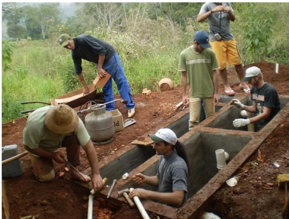
Figura 71: Atividade de mutirão para construção do SMSA
