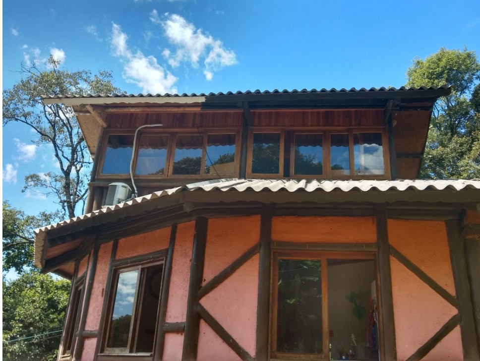
Figura 111: Estrutura feita com eucalipto da propriedade. Foto de 2020.
