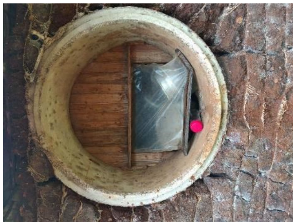
Figura 82: Vista externa da janela da cozinha. As aberturas com o uso de manilhas de concreto apresentam resistência e compatibilidade com a técnica da terra ensacada. Entretanto, a finalização das esquadrias deve ser feita sob medida.
