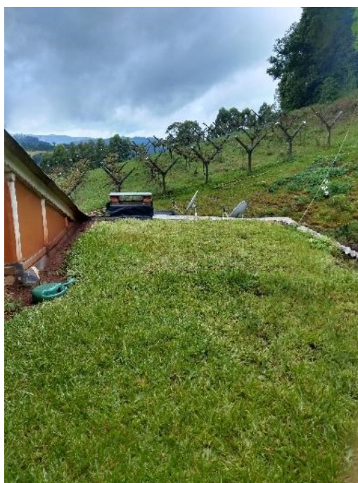
Figura 141: Cobertura ajardinada e parreiral ao fundo (foto de 2020)
