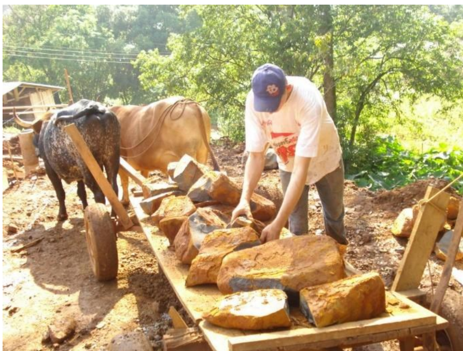
Figura 103: Pedras para execução das fundações e da parede do térreo sendo transportadas em carro de boi (foto de 2009)
