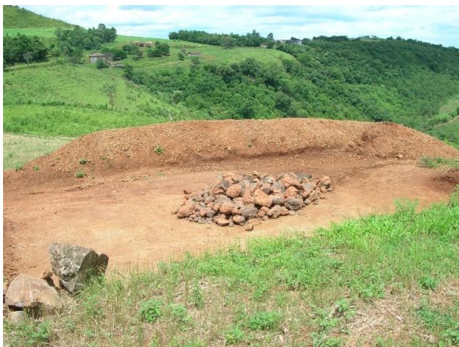
Figura 125: Terraplanagem pronta, com a terra a ser utilizada ao fundo e as pedras utilizadas na fundação no centro do terreno (foto de 2009)
