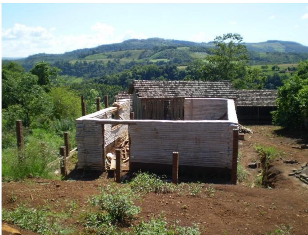
Figura 63: Edificação em etapa de obra, inserida junto às demais construções rurais. Nota-se o recorte no terreno, cuja terra foi utilizada para as paredes.
