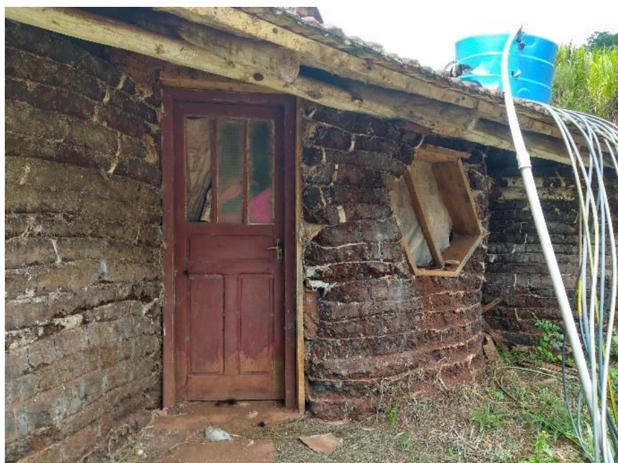
Figura 93: Porta de acesso à área de serviço, visibilidade das paredes de terra ensacada sem revestimento e instalações referentes a um sistema de aquecimento de água com uso de placas solares, desativado no momento da visita de campo. Foto de 2020
