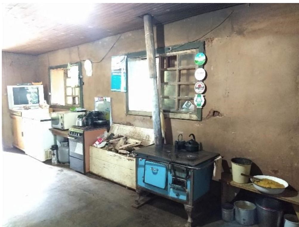
Figura 65: Paredes, piso e forro escuros prejudicam a iluminação natural.
