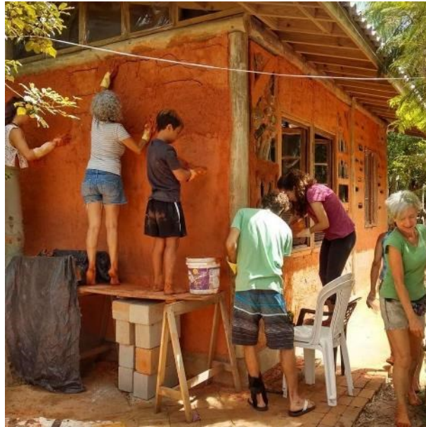
Figura 26: Oficina sobre revestimentos à base de terra realizada em escola de ensino fundamental em Florianópolis - SC. Projeto e execução da autora. Fonte: autora, foto de 2020.
