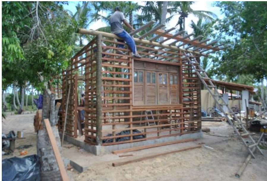
Figura 7: Estrutura de madeira para ateliê em taipa de mão. Projeto e execução da autora. Caravelas, BA, 2017. Foto: autora.
