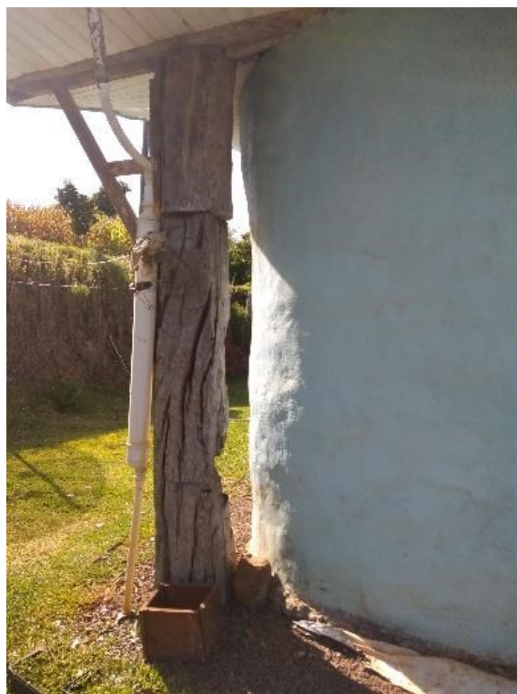
Figura 123: Uso de madeira de demolição. Estruturas e sistema de coleta de água da chuva executadas artesanalmente (foto de 2020)
