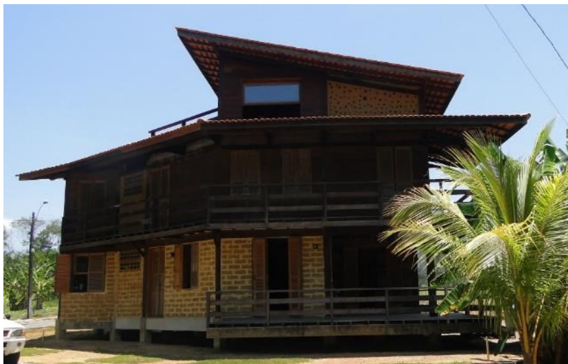
Figura 2: Casa em Macapá. Projeto arquitetônico Arq. Cecília Prompt e Arq. Vika Martins. Execução FN Construções. Consultoria para aplicação com técnicas de construção com terra Raymundo Rodrigues. Foto: Raymundo Rodrigues. Ano: 2012.
