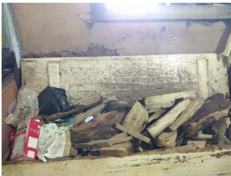
Figura 75: Erosão nas paredes causadas por impacto do mobiliário são percebidas junto à caixa de lenha e à mesa. Foto de 2020.
