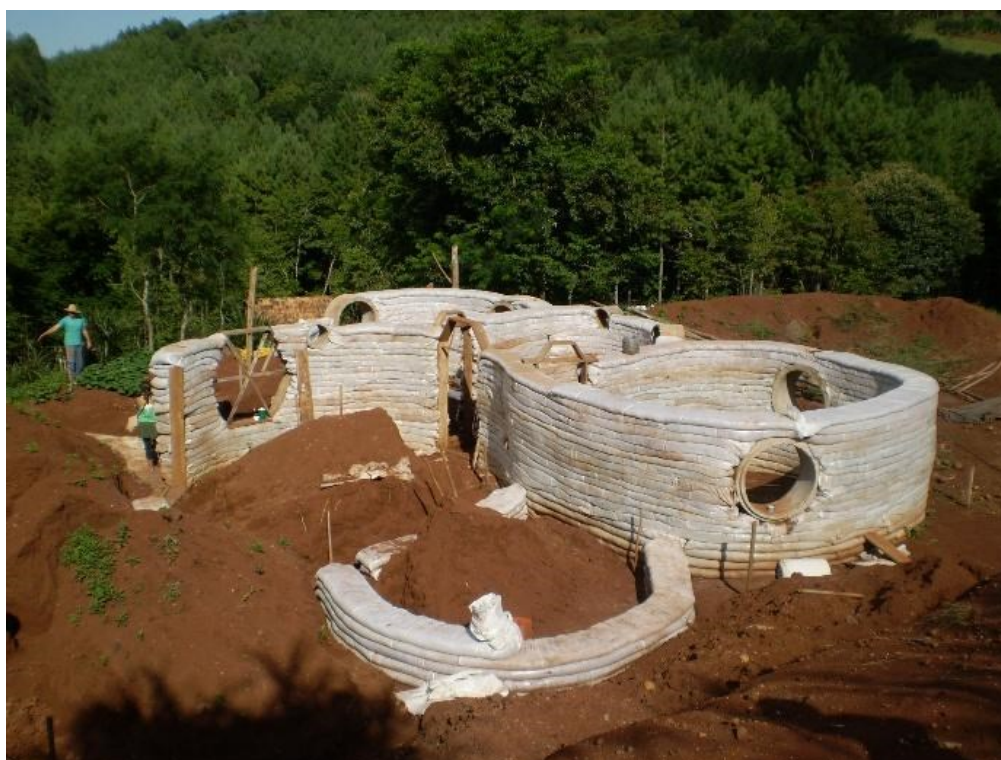
Figura 86: Edificação em etapa de obra: forma e técnica inovadora na região.
