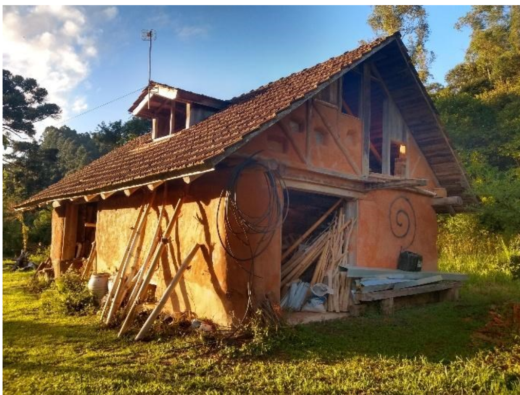
Figura 58: Galpão de terra ensacada construído na propriedade em 2011. Foto de 2020.
