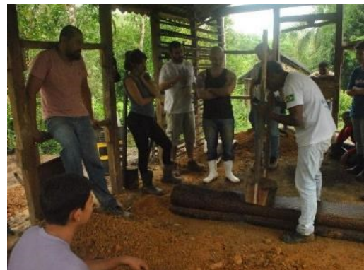
Figura 19: Oficina de construção com terra ensacada. Fonte: Acervo autoral.
