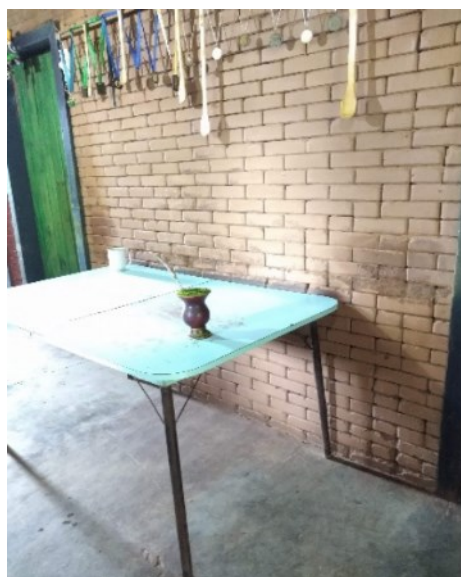
Figura 75: Erosão nas paredes causadas por impacto do mobiliário são percebidas junto à caixa de lenha e à mesa. Foto de 2020.
