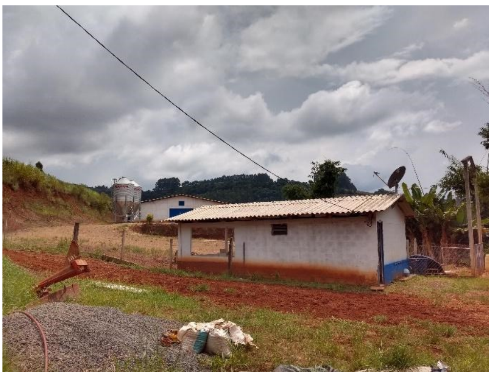
Figura 84: Vista das edificações do complexo do aviário a partir da fachada norte da residência.
