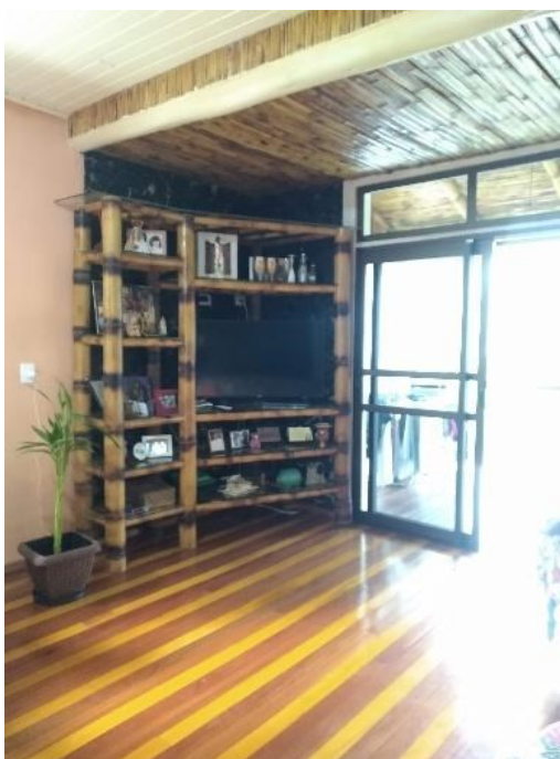
Figura 142: Assoalho com madeira da propriedade beneficiada em serraria local. Uso do bambu no forro e no mobiliário (foto de 2020)
