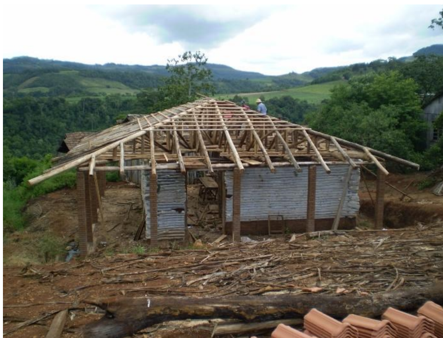
Figura 72: Madeira de eucalipto para a cobertura extraída da propriedade.
