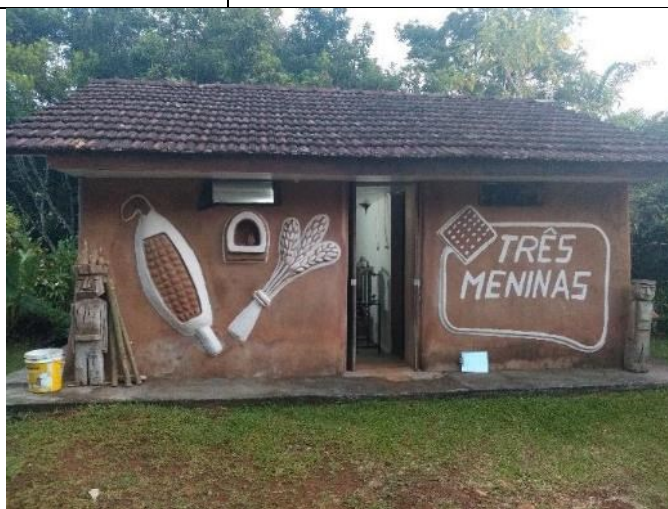
Figura 43: Paredes construídas com terra, cobertura com telha cerâmica de demolição.
