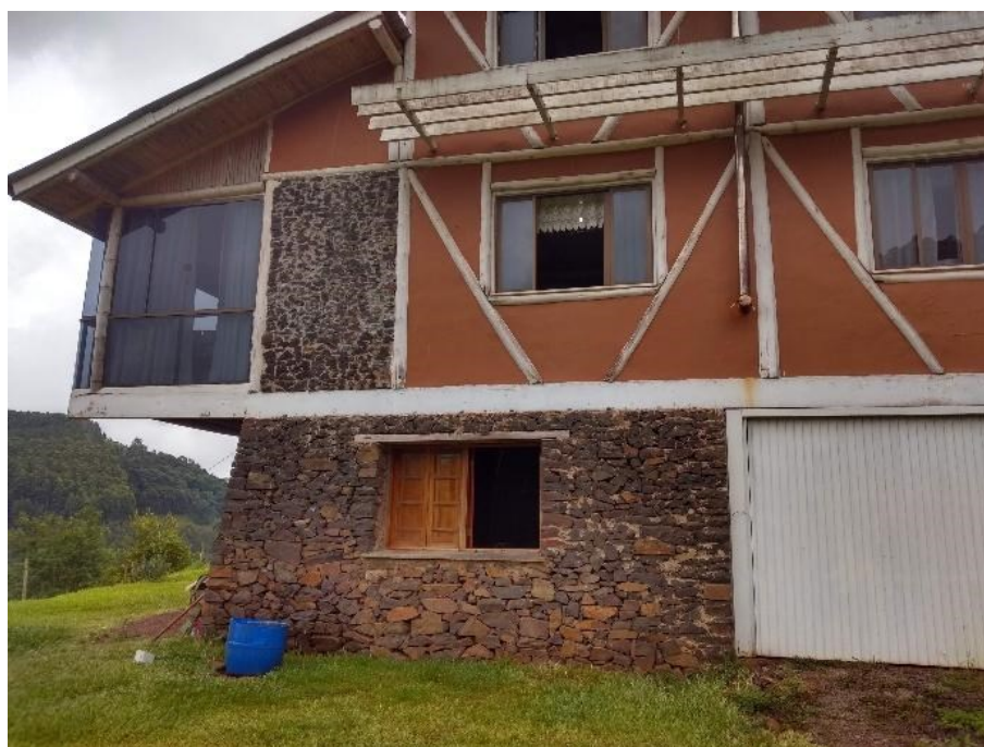
Figura 131: Elementos de sombreamento também auxiliam na proteção da fachada em relação a chuva direta, ainda que de forma insuficiente (foto de 2020)
