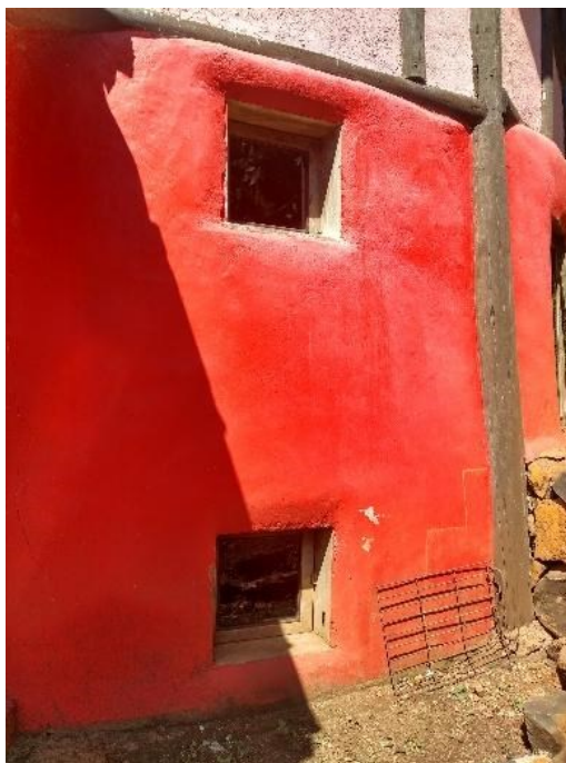
Figura 98: Esquadrias para realização de troca térmica entre a estufa planejada e o ambiente interno foram executadas, mas o sistema não foi finalizado (foto de 2020)
