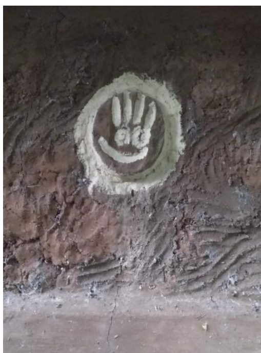
Figura 49: Experimentações com texturas no reboco externo.
