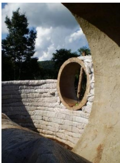
Figura 81: Paredes de terra ensacada com aproximadamente 50 cm de largura podem apresentar elevada inércia térmica. Foto da edificação em obras, 2009
