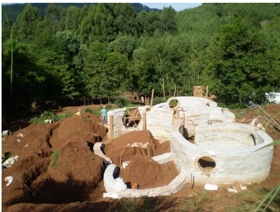
Figura 91: Paredes em terra ensacada demandam grandes volumes de terra (2009) repete figura 86?
