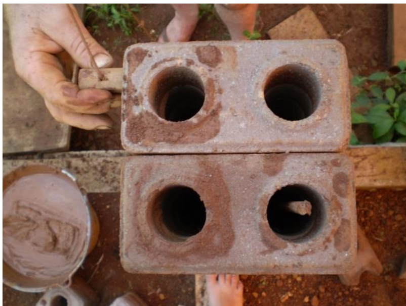
Figura 76: Pilares feitos com BTC's fabricados no local.
