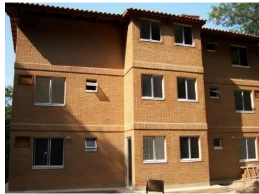
Figura 17: Edificação com uso de BTC estrutural. Fonte: Ecoblocos.
