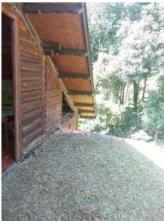
Figura 106: Vista do telhado vivo acessado pelo sótão. Detalhes expressam as habilidades da família com o uso da madeira. Ao fundo, zona abaixo da cobertura sem vedação (foto de 2020)
