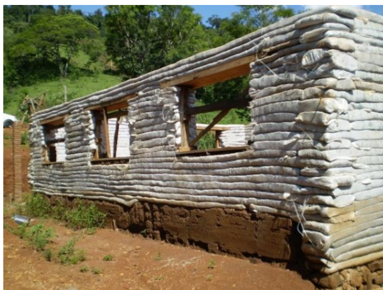
Figura 74: À esquerda, execução de paredes em taipa de pilão com o solo local. À direita, paredes de terra ensacada apoiada sobre base de taipa de pilão. Foto de 2009.
