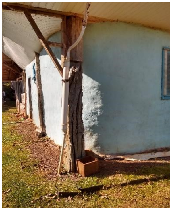
Figura 113: Pilares para escoramento da cobertura adicionados após a execução da mesma (2020)
