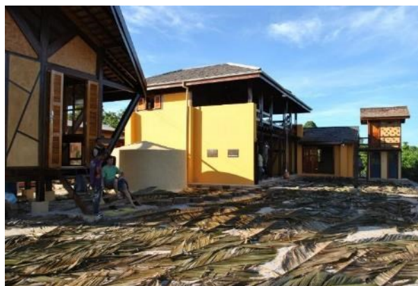
Figura 22: Base de apoio da REBIO Piratuba, construída com terra ensacada, taipa de mão e painéis de serragem com solo-cimento. Fonte: Acervo autoral.
