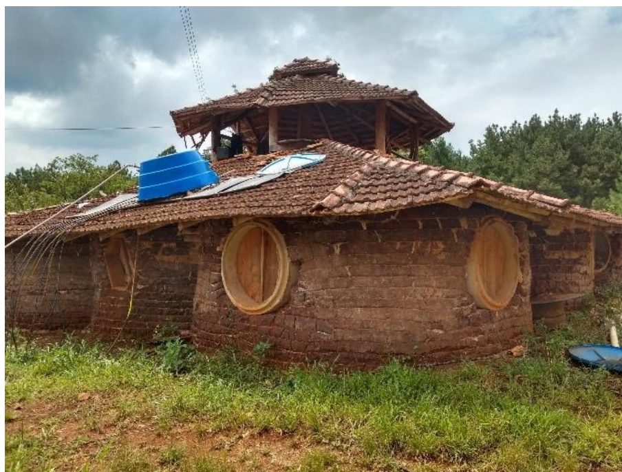
Figura 89: Vista face noroeste da edificação. Foto de 2020.
