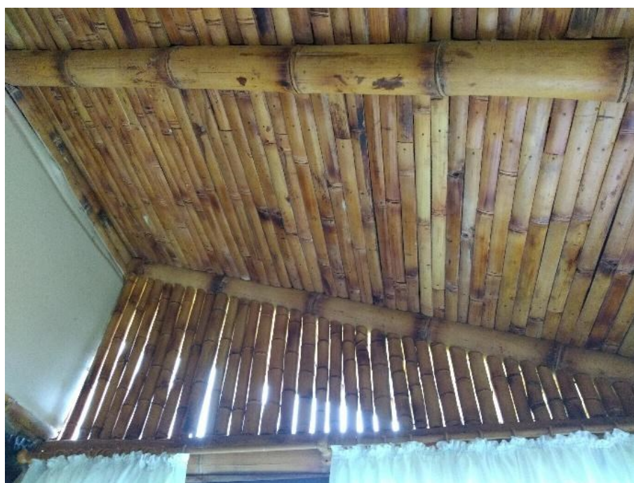
Figura 138: Uso do bambu em elementos construtivos, como no forro da varanda (foto de 2020)
