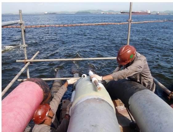
Figura 3 - Aplicação de revestimento em material compósito realizado em campo (Rust Engenharia, 2020).
