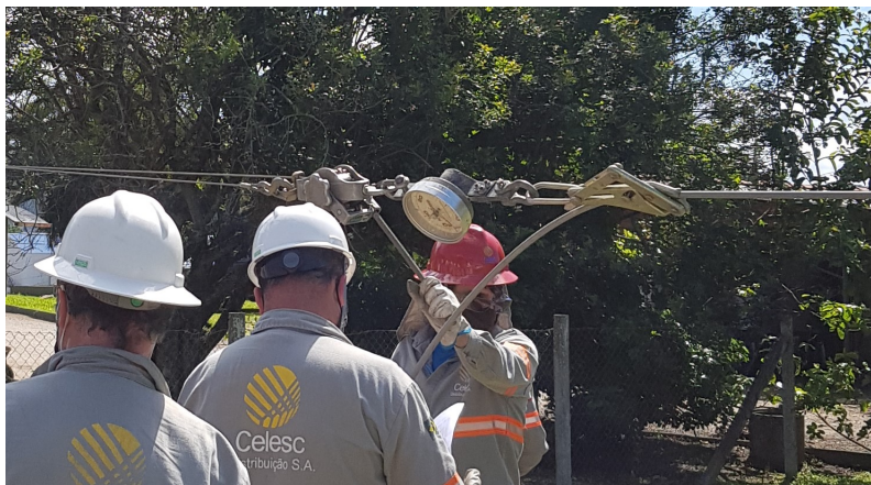
Figura 36 – Sistema de tracionamento com uso de catraca.
