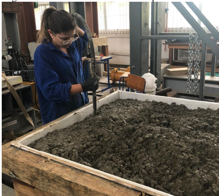
Figura 28 – Adensamento mecânico da placa de concreto.
