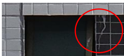
Figura 9 e 10: Apresentação de eflorescência nas fachadas Norte e Oeste. Fonte: Elaborado pelos autores (2019).
