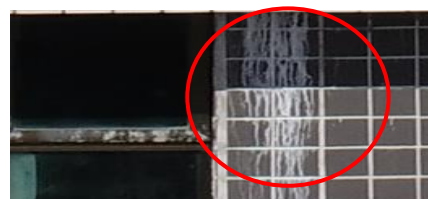
Figura 9 e 10: Apresentação de eflorescência nas fachadas Norte e Oeste. Fonte: Elaborado pelos autores (2019).
