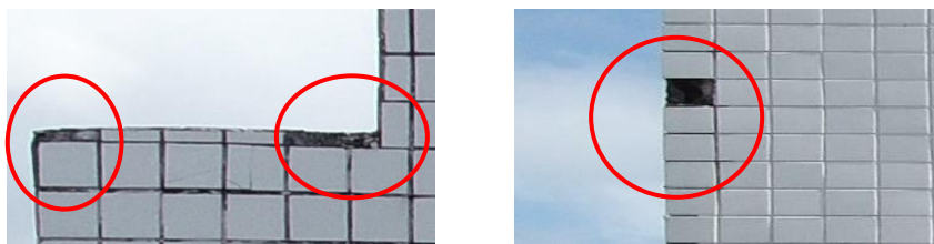
Figura 11 e 12: Apresentação de destacamento na fachada Sul. Fonte: Elaborado pelos autores (2019).
