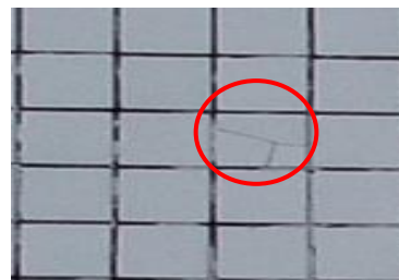
Figura 7 e 8: Apresentação de fissura nas fachadas Oeste e Sul. Fonte: Elaborado pelos autores (2019).
