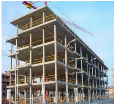
**Figura 3 – Sistema viga-pilar em concreto armado. Fonte: Zanollin Soluções Estruturais.**
