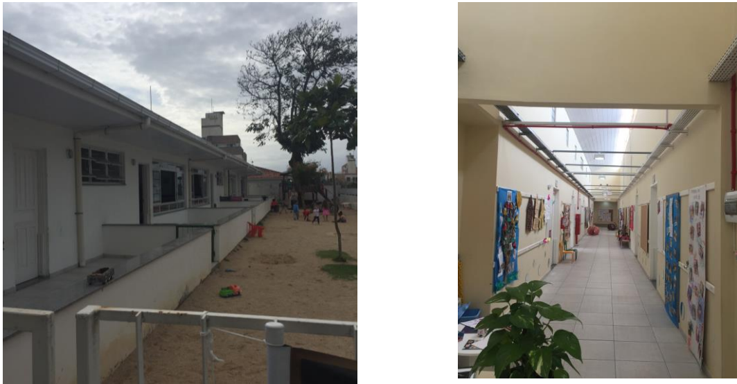
Figura 10 - Fachada externa e corredor interno na escola de ensino infantil B08
