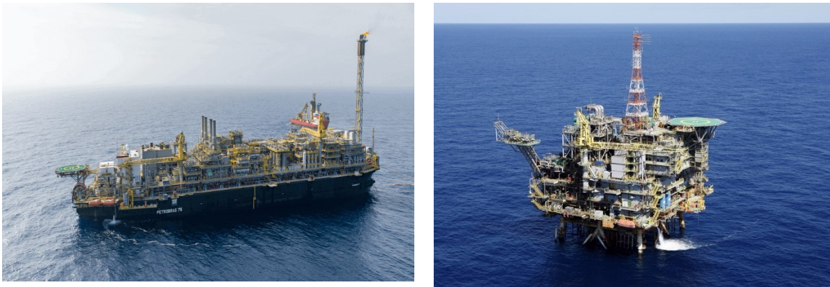
Figura 3 – (a) exemplo de unidade flutuante de produção. (b) exemplo de plataforma fixa.
