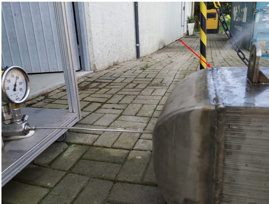
Figura 6.30 - Novo vazamento na região de solda entre o bocal e o núcleo.
