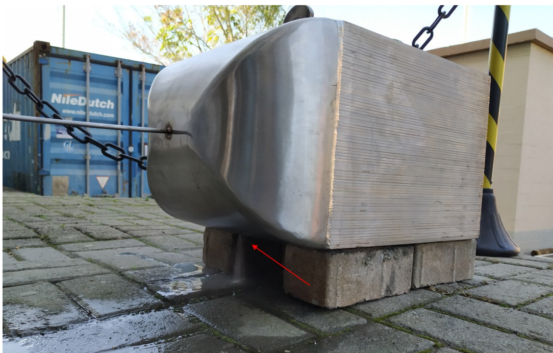
Figura 6.24 - Vazamento concentrado na solda entre o bocal e o núcleo.
