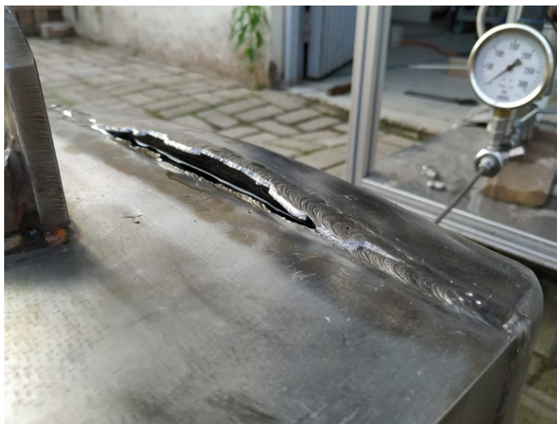
Figura 6.31 - Rompimento na região de solda entre o bocal e o núcleo.
