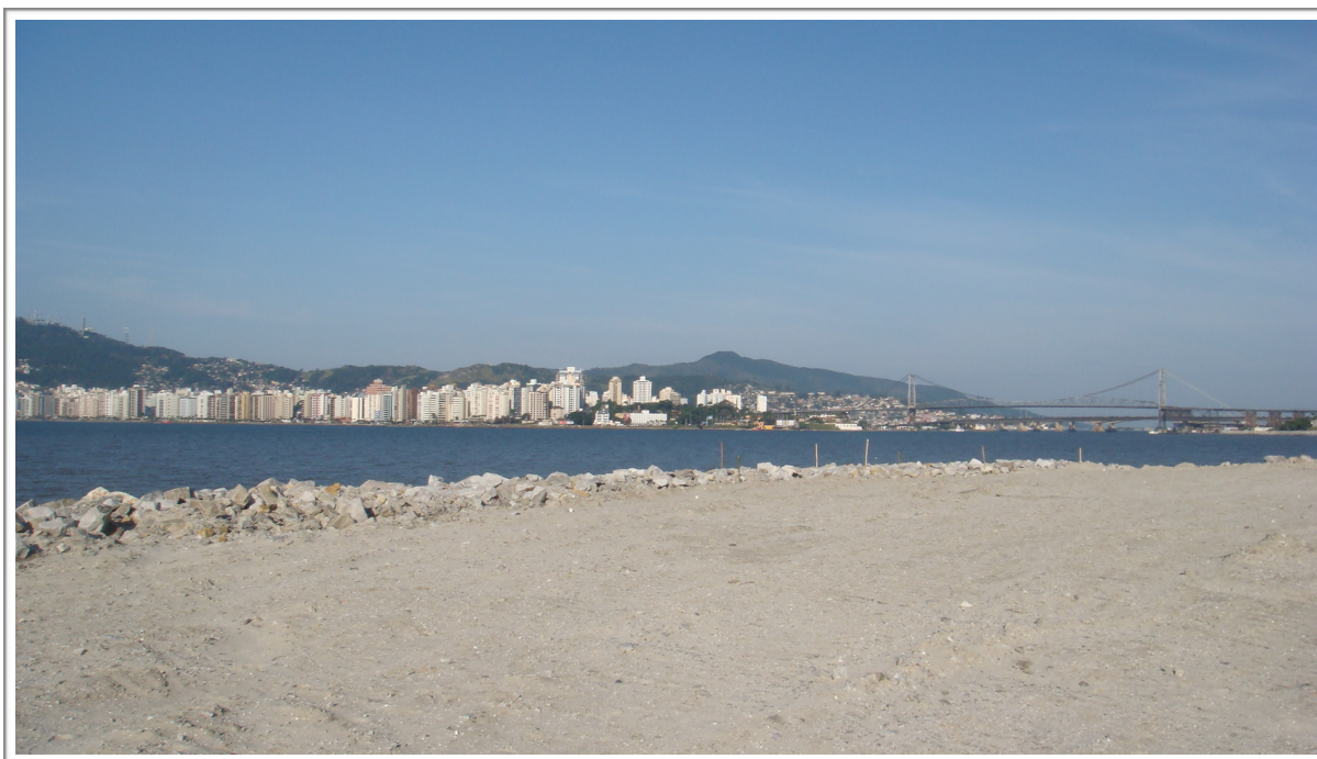
Figura 24 – Obras do aterro da Avenida Beira-Mar Continental, no bairro Estreito, Florianópolis, anos 2000
