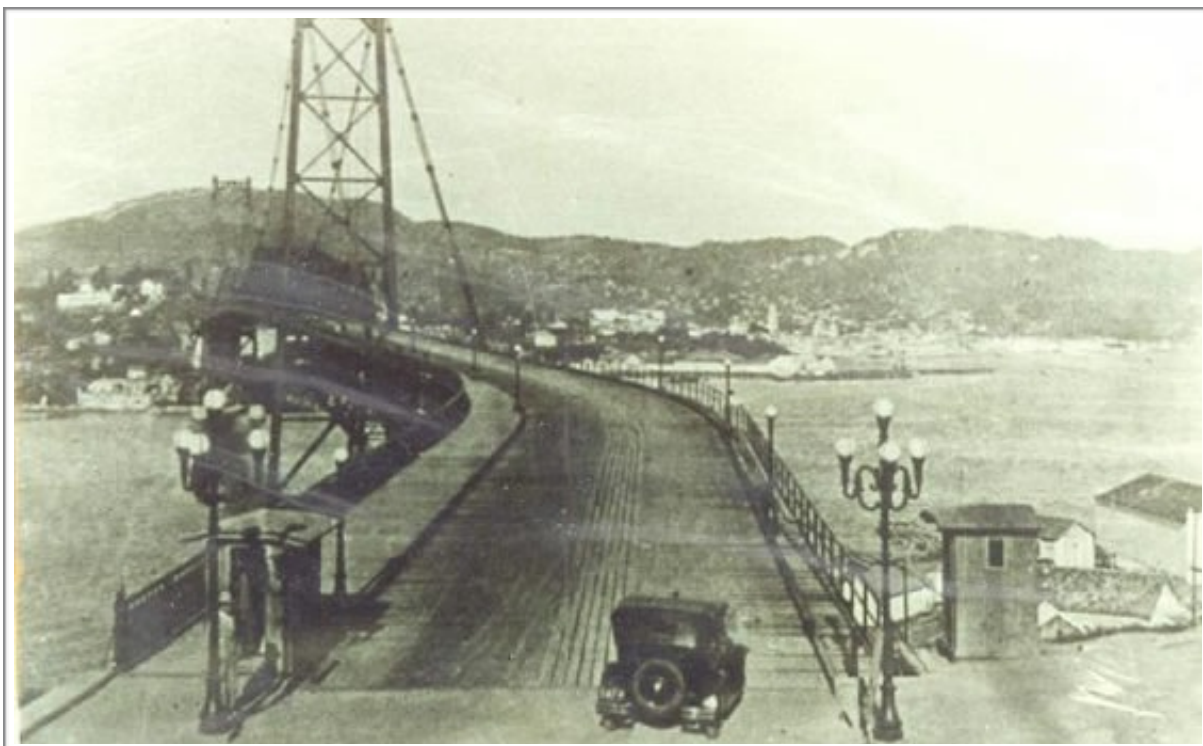
Figura 28 - Ponte Hercílio Luz, década de 1930
