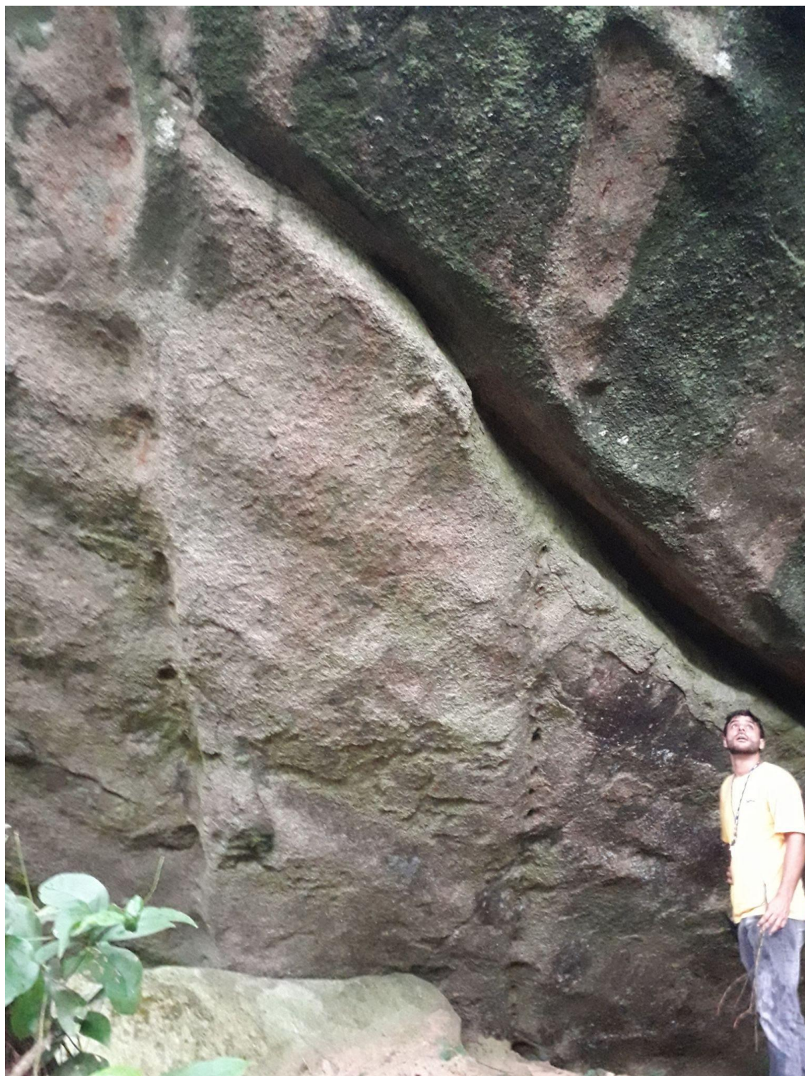
FIGURA 13: Hotel SESC Cacupé Afloramento rochoso e gestor ambiental como base de medida ( FOTO Renan da Costa)
