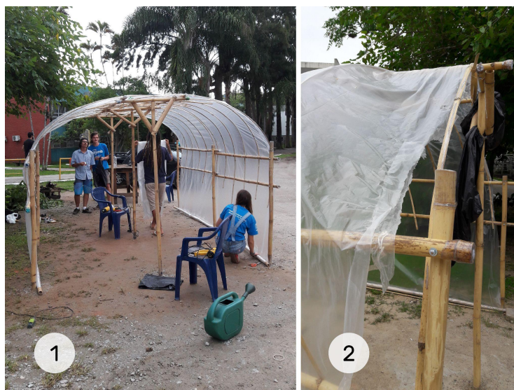
Figura 07: Construção do viveiro utilizando lona (1); danificação (2)
