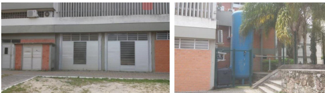
Figura 08: Portas que prevêm acessos para veículos.
