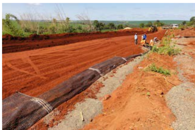
Figura 28 - Envelopamento da borda da geogrelha.
