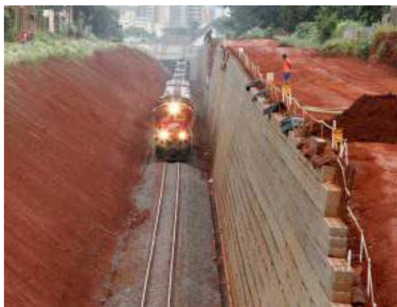
Figura 42 - Execução da obra de contenção.
