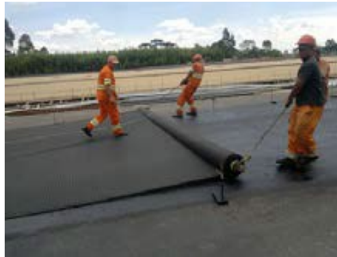
Figura 36 - Instalação da geogrelha.
