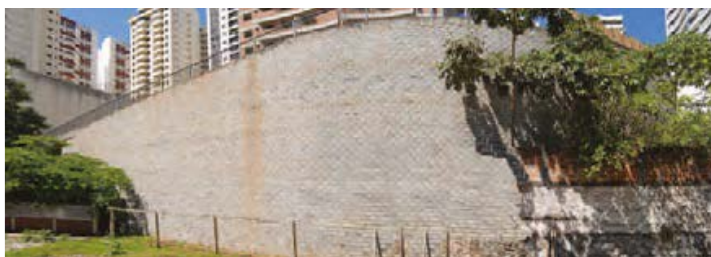
Figura 39 - Muro no condomínio.
