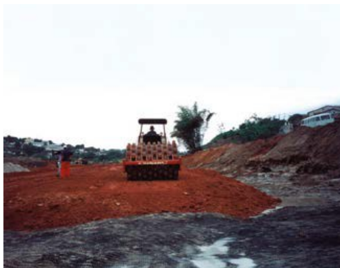
Figura 23 - Obra sobre aterro sobre solos moles.
