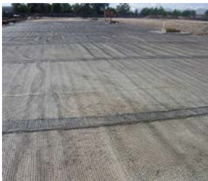
Figura 34 - Processo de execução do pavimento com geogrelha.
