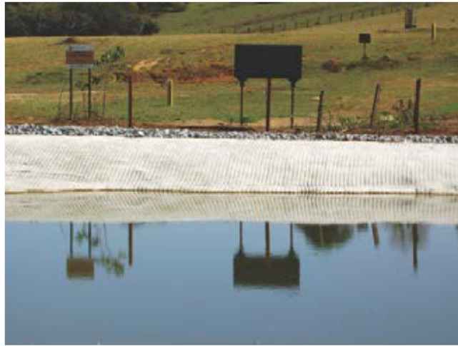
Figura 48 - Vista do talude finalizado.
