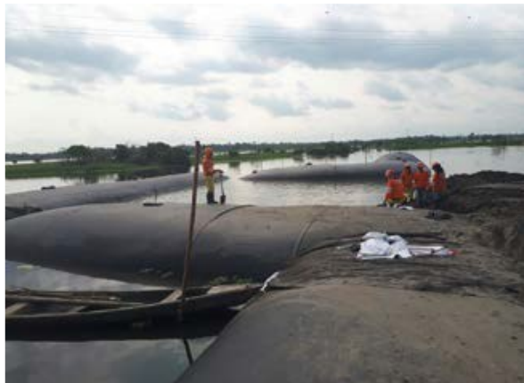
Figura 53 - Conformação dos diques de contenção com tubos para a construção da plataforma em aterro hidráulico.
