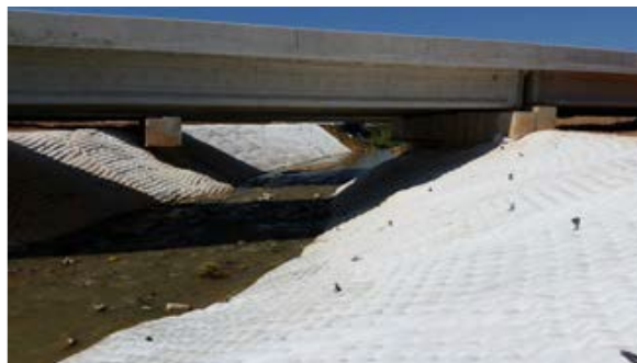
Figura 50 - Vista geral da obra pronta.
