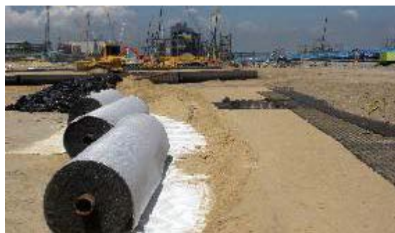
Figura 26 - Geossintéticos na espera durante a execução da obra.
