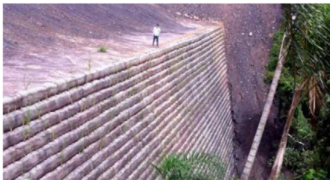
Figura 43 - Imagem do muro após o término da construção.
