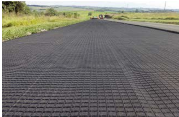
Figura 38 - Vista da geogrelha instalada.
