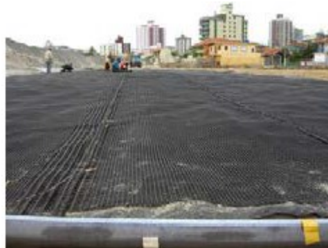
Figura 25 - Colocação dos megapainéis de geossintéticos.
