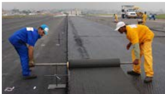
Figura 33 - Aplicação da solução com geossintéticos.
