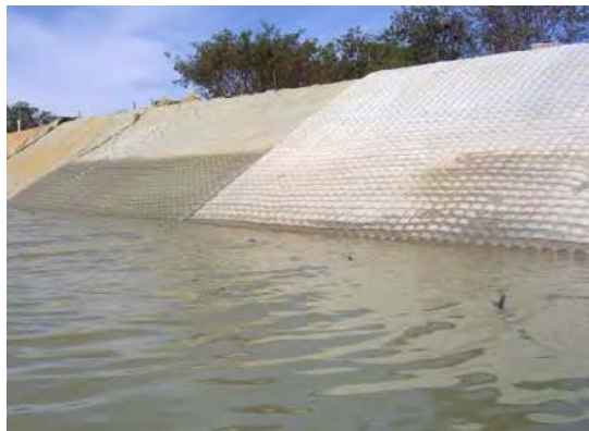
Figura 47 - Revestimento do canal.
