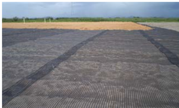
Figura 30 - Aterro reforçado na base com geogrelhas.
