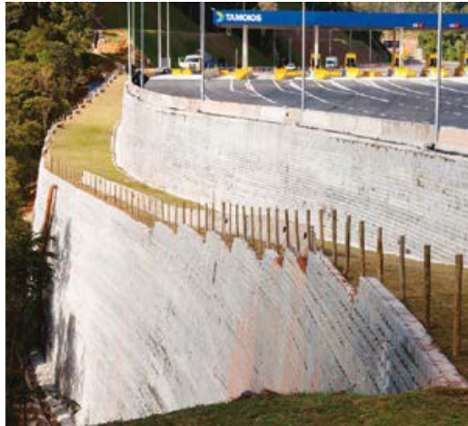
Figura 45 - Obra finalizada com a contenção.
