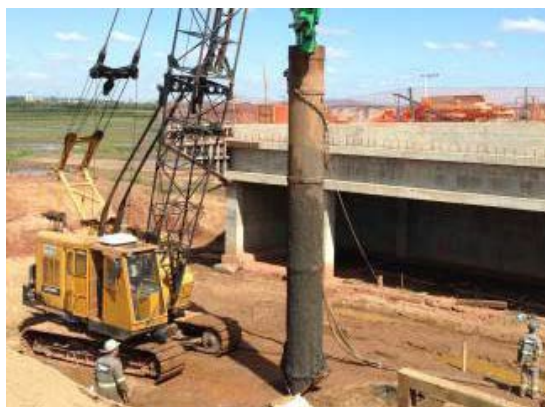
Figura 29 – Colunas granulares encamisadas na execução da obra.
