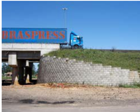
Figura 41 - Muro como contenção.
