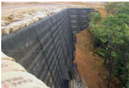
Figura 46 - Detalhe das geogrelhas em espera para realizar envelopamento invertido.
