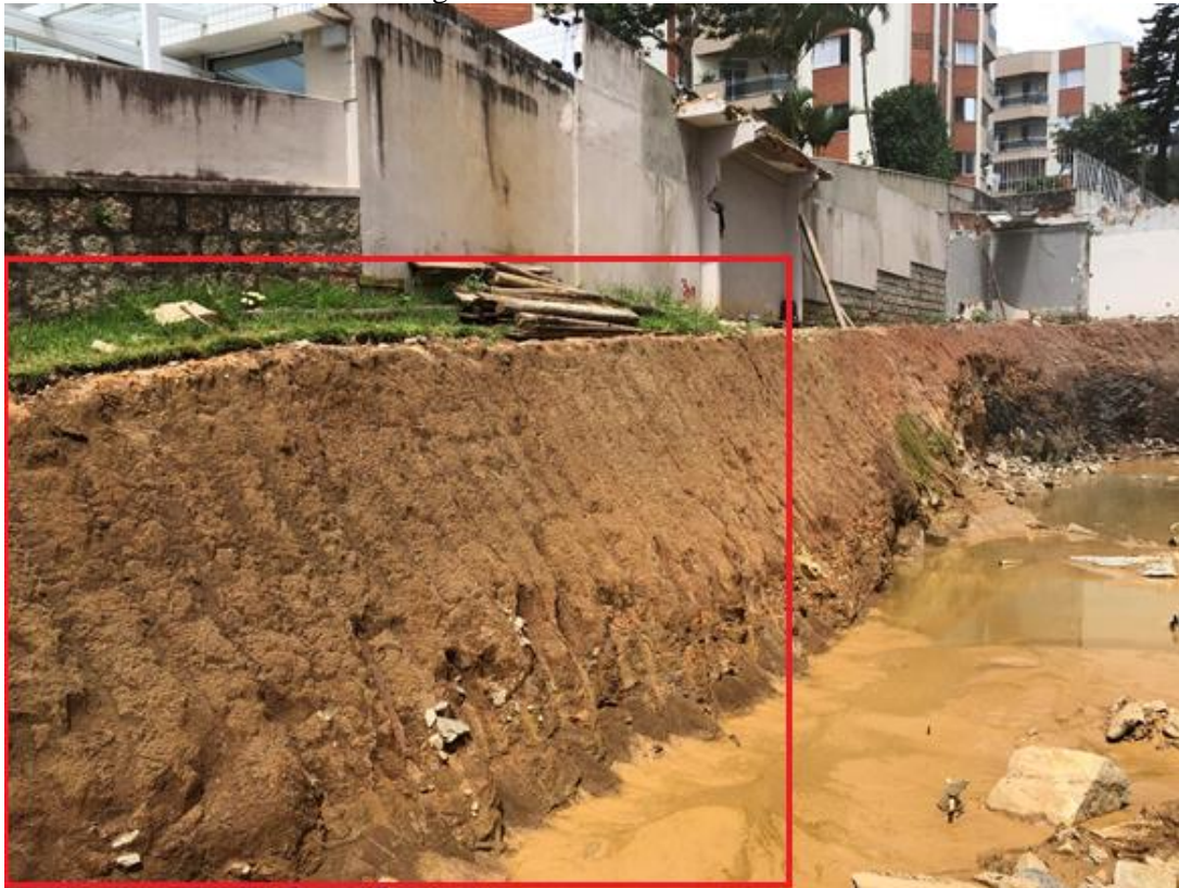
Figura 19 - Talude em estudo
