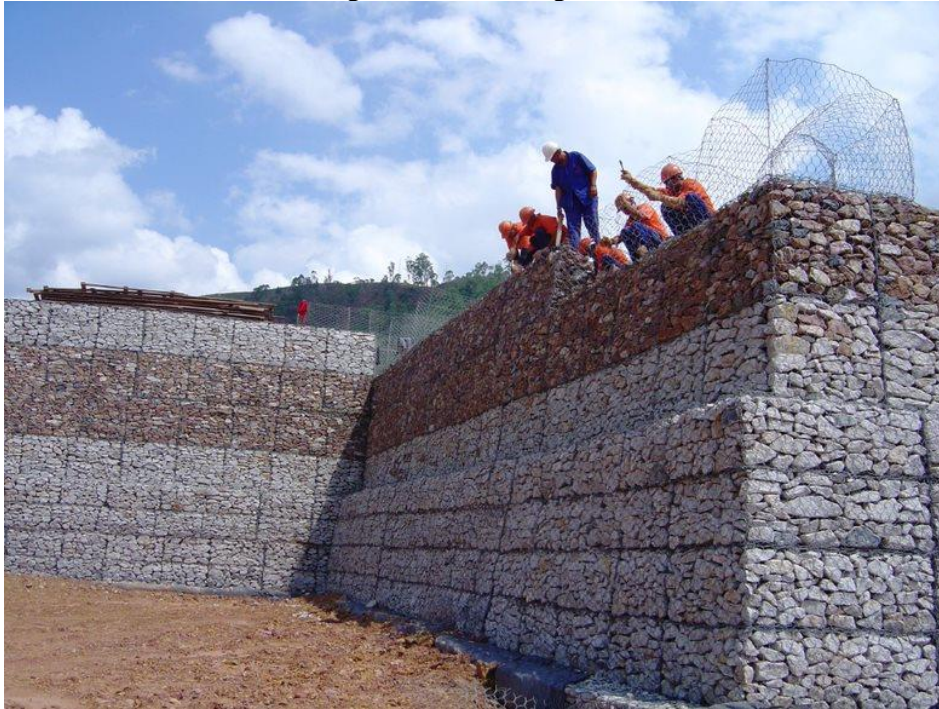
Figura 6 - Muro de gabião
