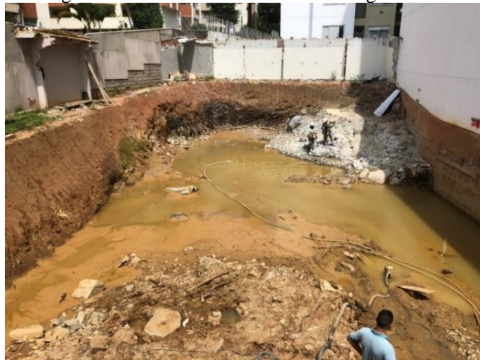
Figura 17 - Terreno da obra em seu estágio inicial
