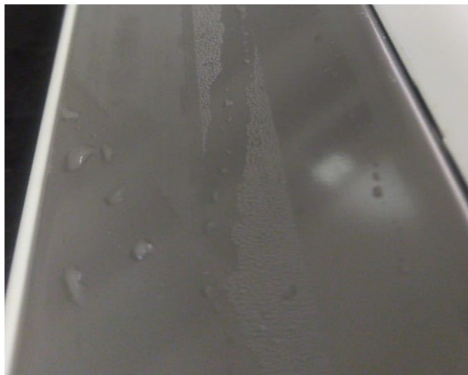
Figura 15 – Condensação de água no batente móvel
