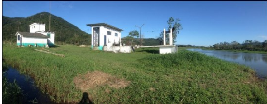
Figura 13 - Estrutura física da captação.
