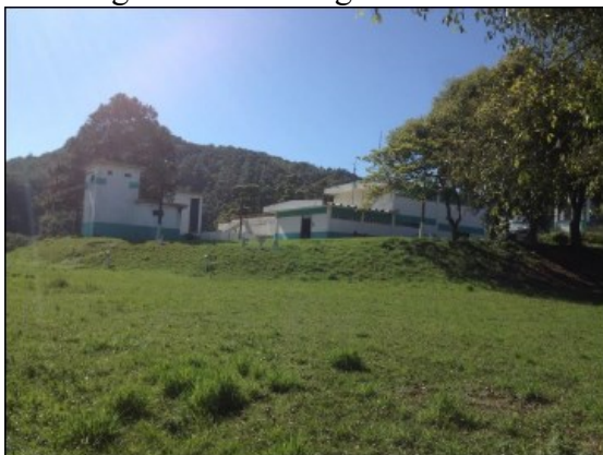
Figura 14 – Vista geral da ETA.
