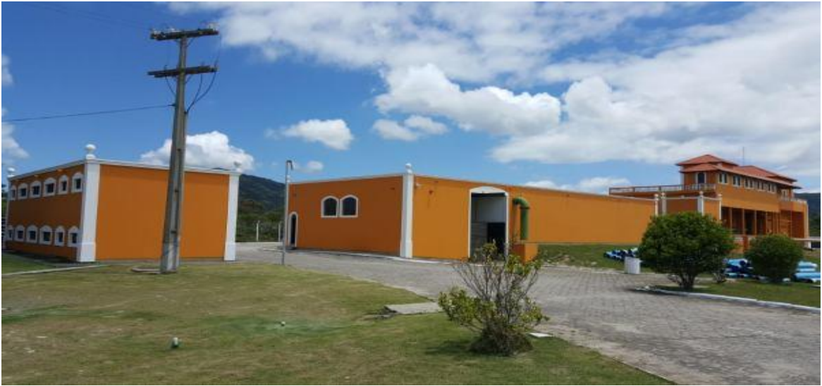
Figura 1 - Foto da ETA Lagoa do Peri
