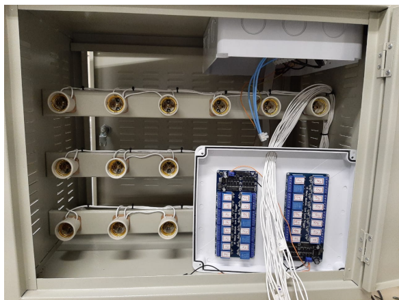
(a) Montagem Módulo de Cargas
