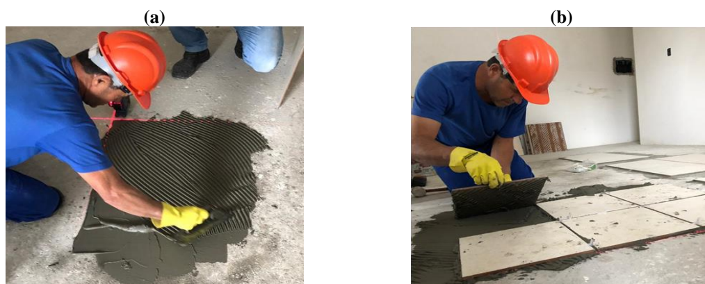
Figura 2. Aplicação de Argamassa: (a) Sobre o Substrato, (b) Sob a Placa em caso de Dupla Camada.
