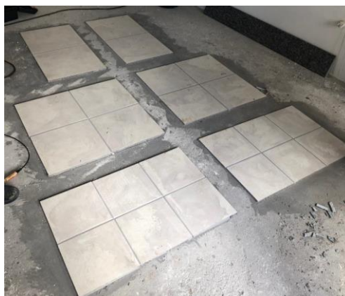
Figura 3. Placa Cerâmica Após o Rejunta
