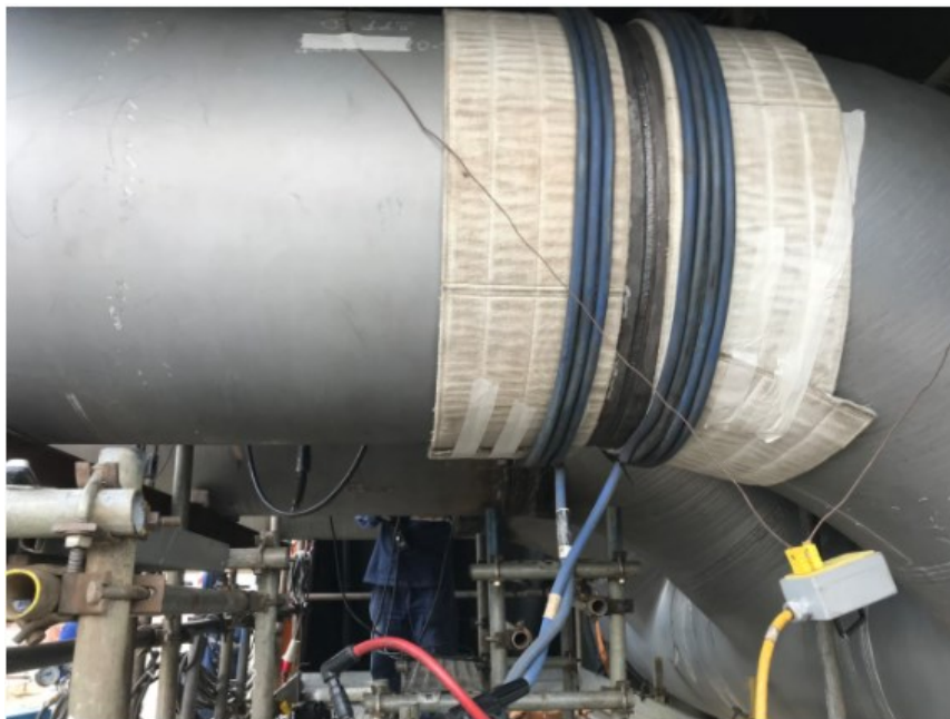
Figura 10 - Bobina de indução em torno da peça de trabalho
