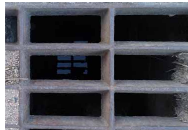
[Figura 89: Bueiros na avenida. Fonte: acervo da autora, 2019]
