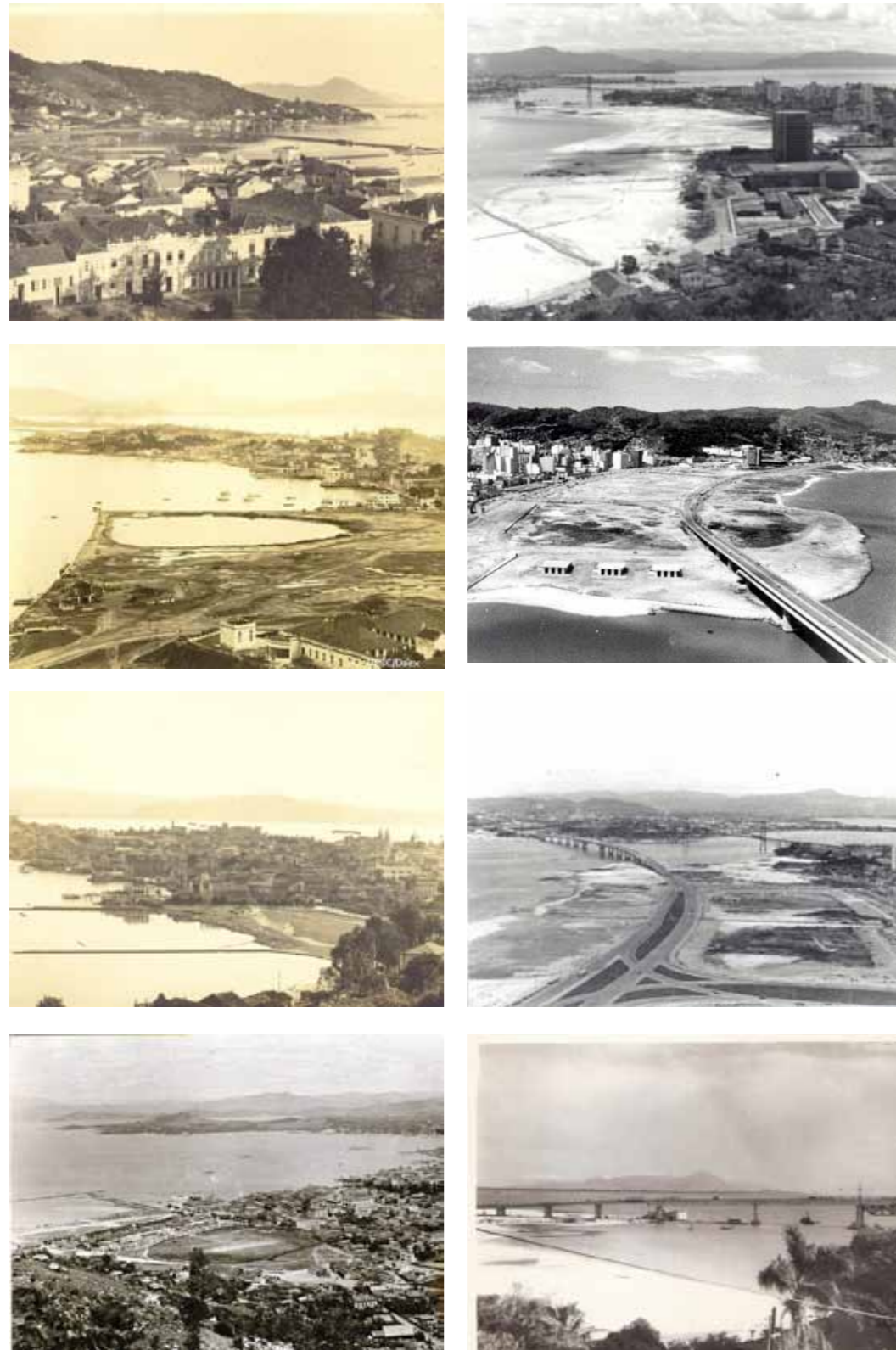
[Figura 16: Nas fotografias da esquerda os primeiros aterros da baía sul, nas fotografias da direita o aterro da década de 70. Fonte: < http://fotosantigasflorianopolis.blogspot.com > Acesso em 09/08/2019]
