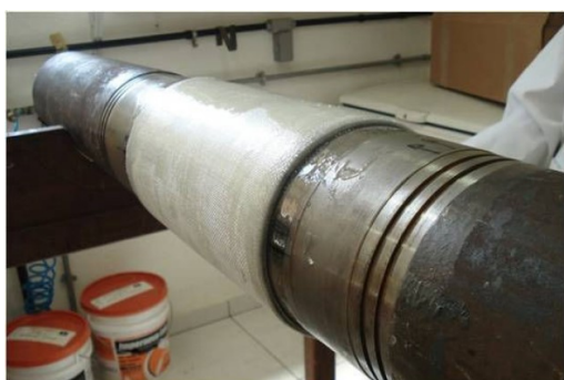
(a) Pipe repair (BUDHE et al., 2018).
