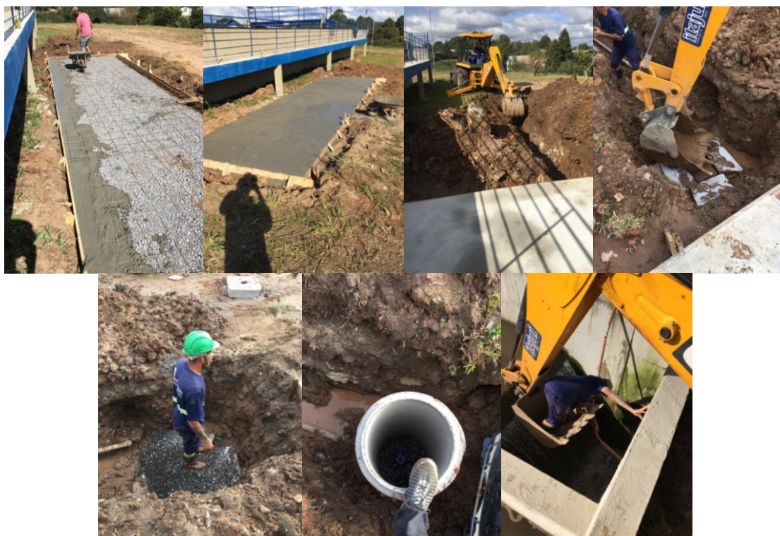
Figura 10 – Etapas da construção civil do experimento
