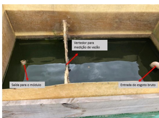
Figura 12 – Caixa de armazenamento e distribuição do esgoto para o módulo WV-SF
