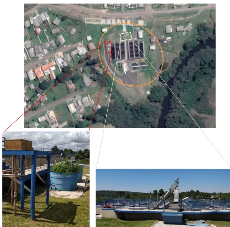
Figura 9 – Vista geral da ETE Araucária, localizada em Lages/SC, e em destaque o módulo piloto de WV-SF
