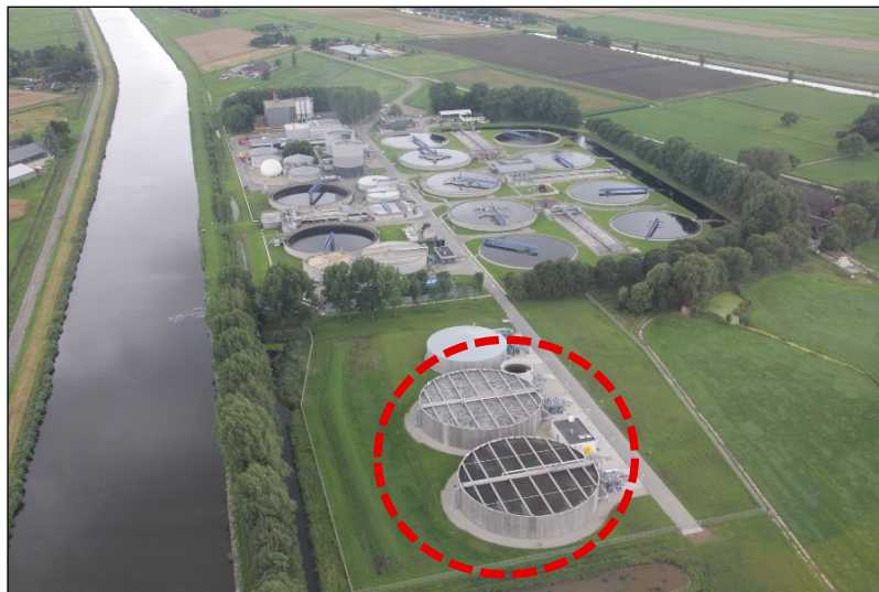
Figura 7 - reatores em bateladas sequenciais com lodo granular (em destaque) operantes na ETE de Gamerwolde na Holanda.
