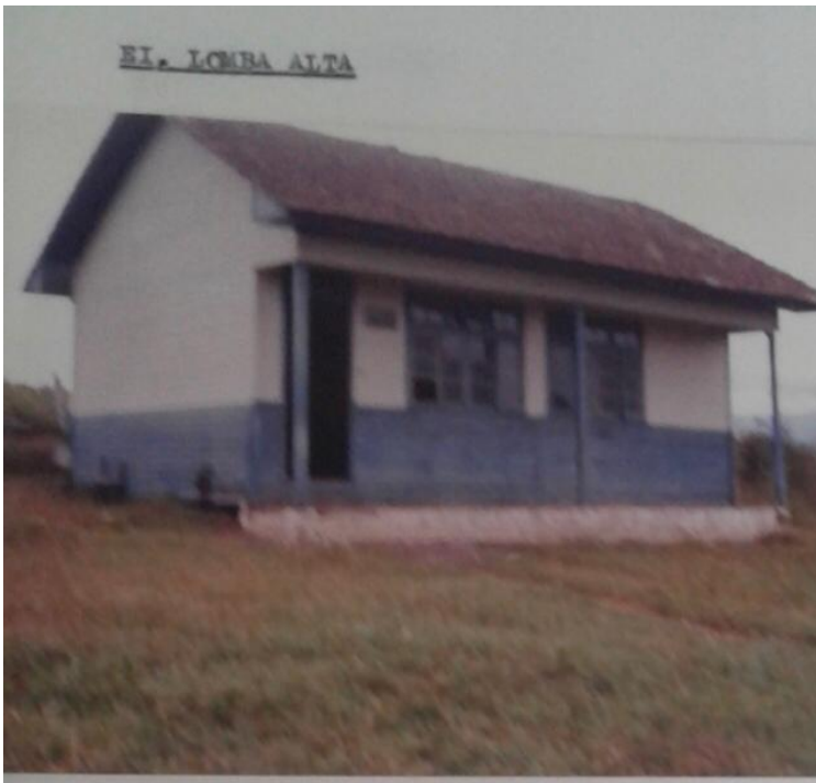
Figura 13: Primeiro prédio – Escola Isolada Lomba Alta (1963)
