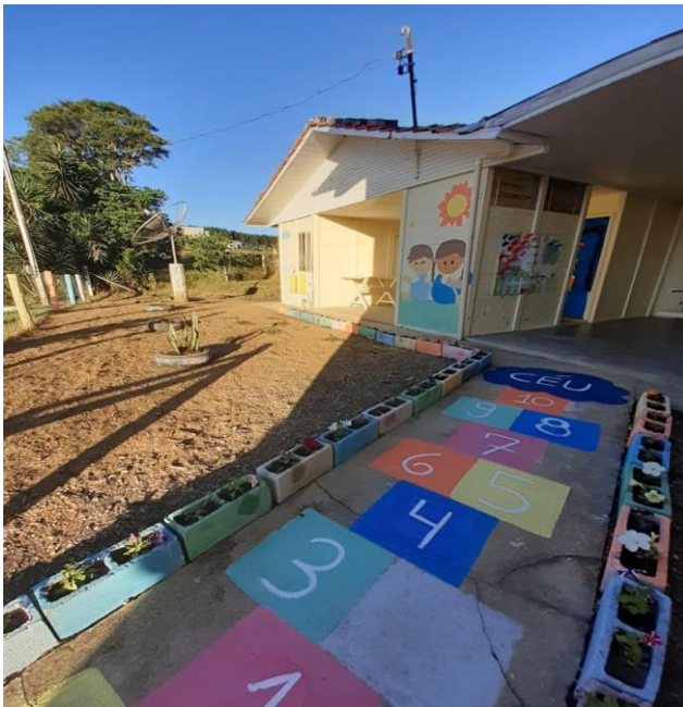
Figura 09 : Escola Isolada Lomba Alta durante a reforma
