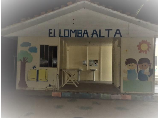
Figura 10 : Escola Isolada Lomba Alta após a reforma
