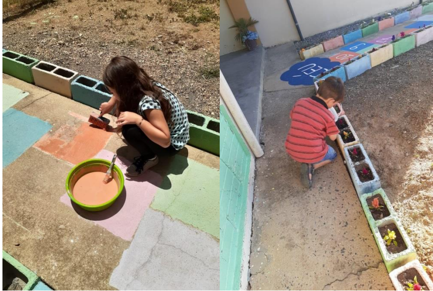
Figura 08 : Escola Isolada Lomba Alta durante a reforma
