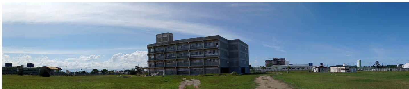
Figura 07 - Edifício em construção Fonte - Acervo DPAAE / UFSC
