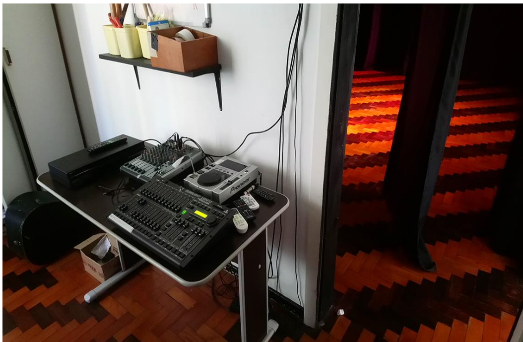
Figura 6: Sala técnica. Foto: Jefferson Bittencourt
