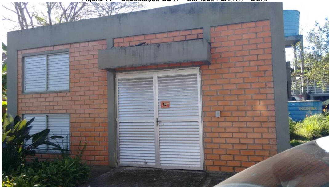
Figura 11 – Subestação SE47 - Campus FLN.ITA - CCA.
