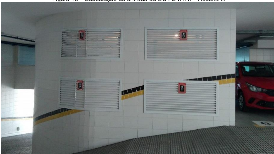
Figura 13 – Subestação de entrada da UC FLN.TRI – Reitoria II.
