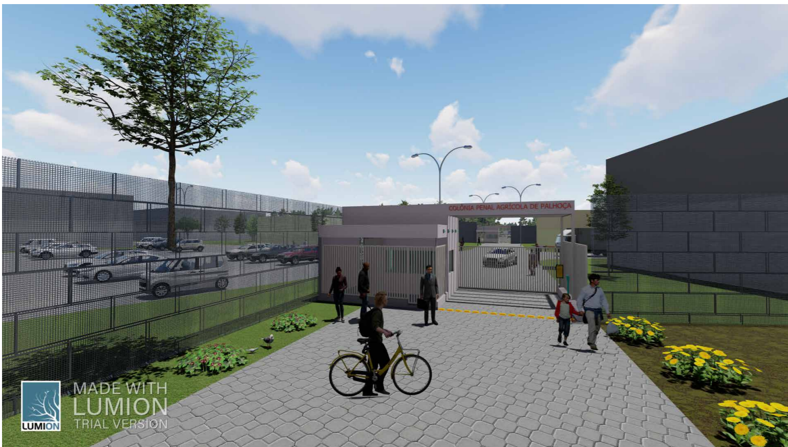
Portaria que separa a zona comunitária da zona intermediária
