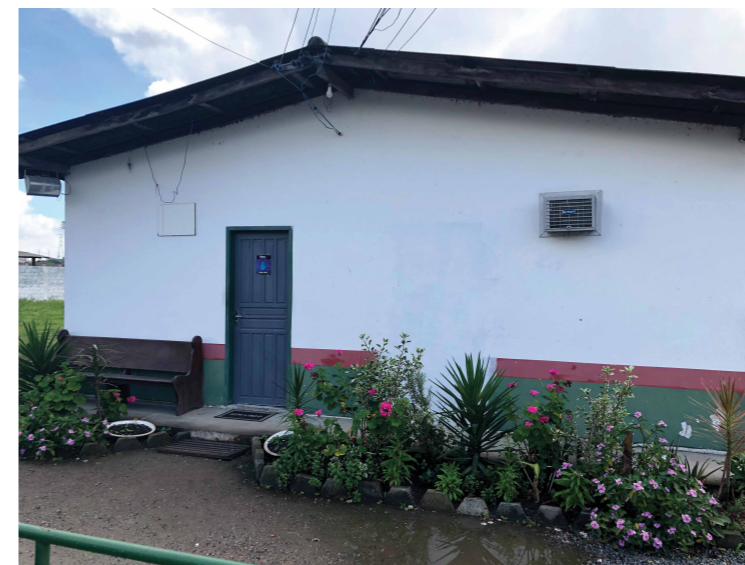
Fachada da edificação onde são feitas as revistas de internos e visitantes Fonte: Autora (2020)
