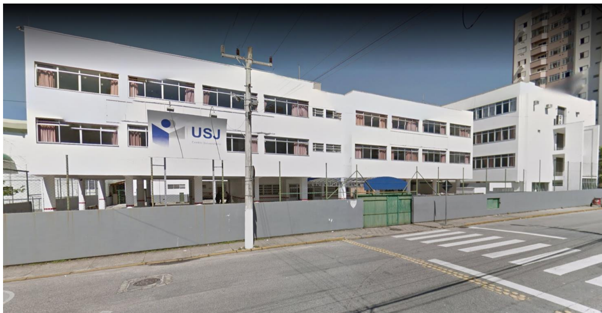
Figura 1: lateral da escola - (blocos A, B e C) 3
